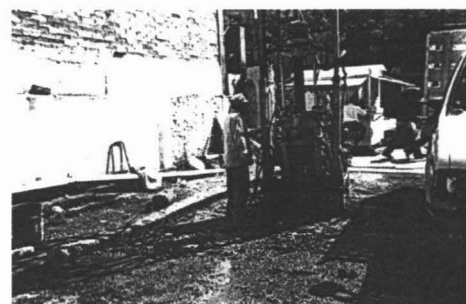
Colocación de la maquinaria de perforación
