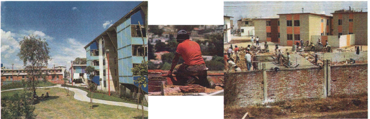
Apoyo en construcción de vivienda nivel medio
