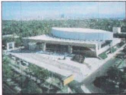
Foto 47 Vista aérea del conjunto del Auditorio Nacional.
