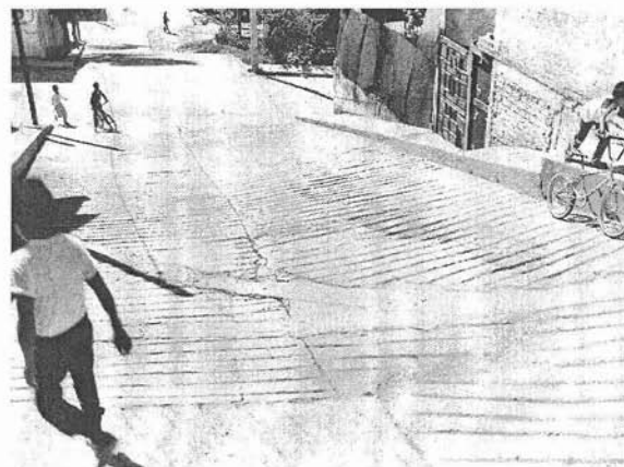
Fig. 51 Imagen de una de las calles en donde se construyó una rampa para poder facilitar el desplazamiento de la población en la zona del Cerro del Judío.
