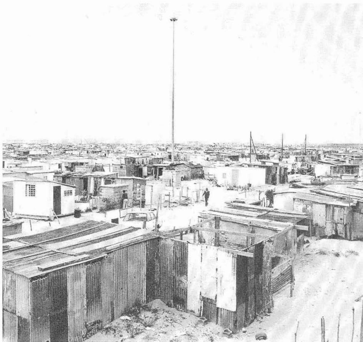
Fig. 18 Nueva conglomeración poblacional, en las afueras de un centro urbano en una ciudad al este de África. Este tipo de situaciones es cada vez mas frecuentes en las ciudades del orbe, debido primordialmente a la falta de espacio definido para poder subsanar la cada vez mayor migración del campo a la ciudad.
