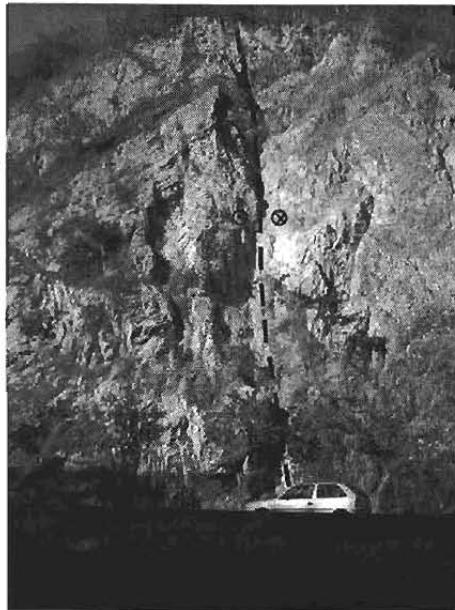
Figura V.38.- Imagen que muestra una falla lateral izquierda que afectó a migmatitas (kilómetro 13 del Viaducto Diamante).
