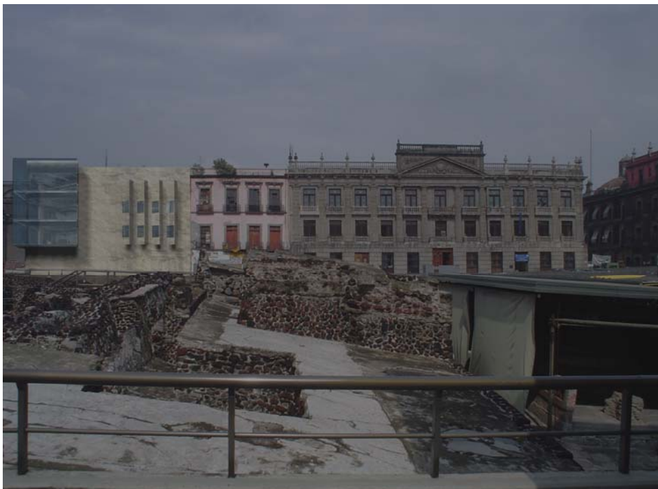
Vista exterior, Fachada sobre Argentina,
