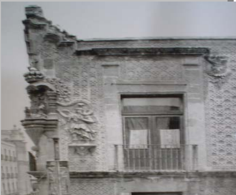
Esquina representativa de la Casa. Fuente : INAH
