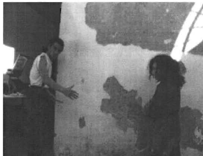
Foto 33 Reparación del muro Romano con ayuda de espátula y cepillo de alambre se retiran capas derruidas
