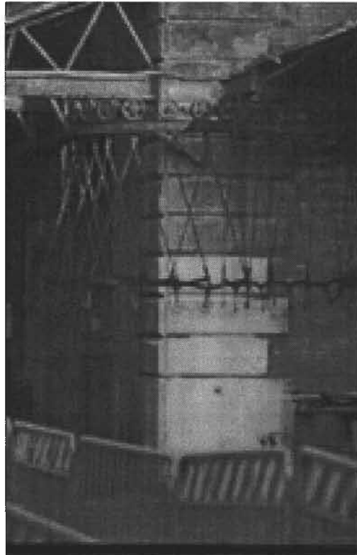
Foto 2 Instalaciones del viejo rastro de Roma
