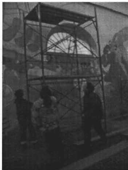
Foto 17 Se observa andamio con ruedas, el cual agilizó el trabajo y permitió ver en su totalidad el muro durante el proceso
