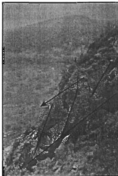
Figura 6.8 Bloques de roca con fracturas a favor del deslizamiento.
