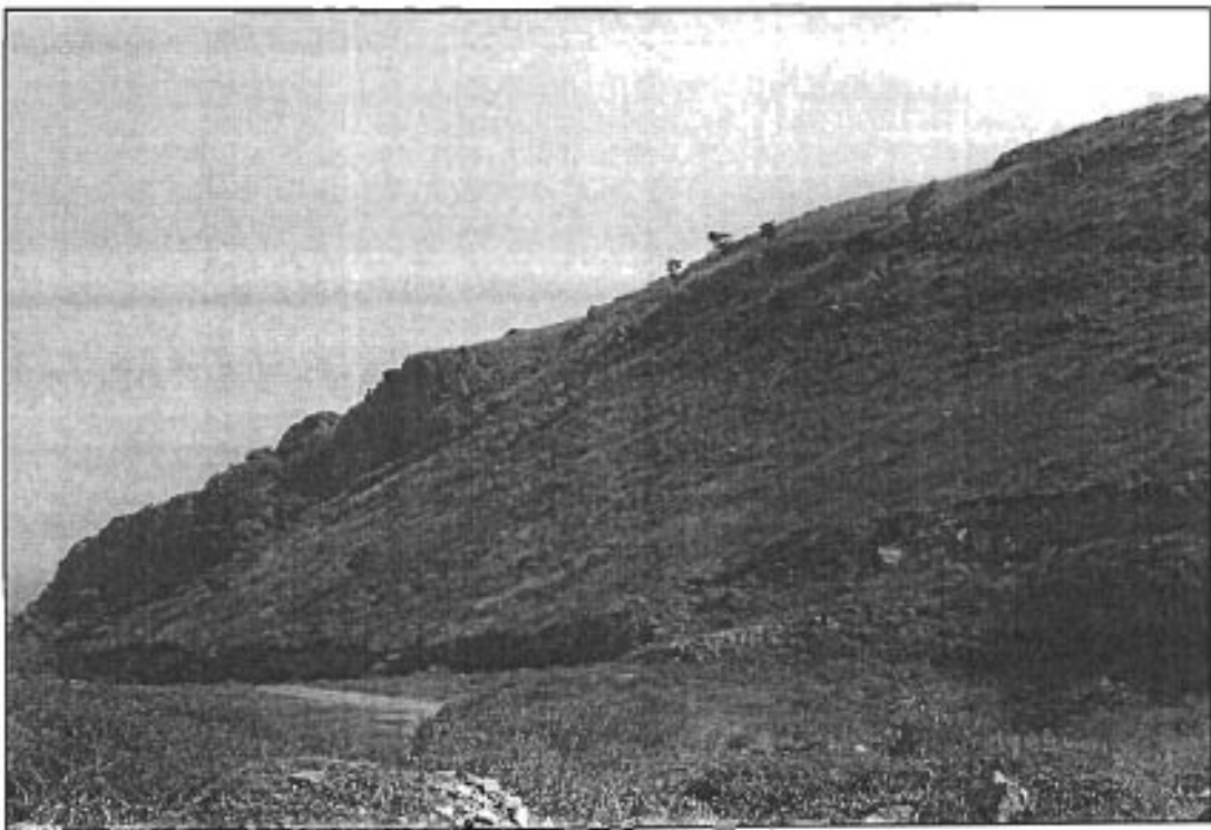
Parte Norte del cerro Las Peñas Ladera con movimiento de reptación
