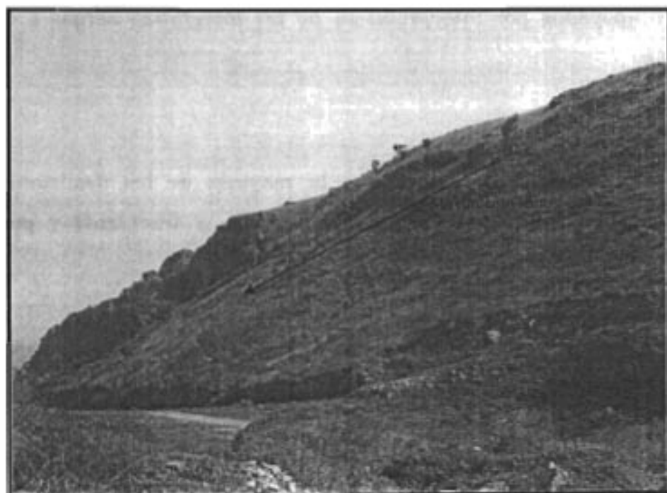
Figura 6.11. Ladera afectada por reptación superficial y profunda.
