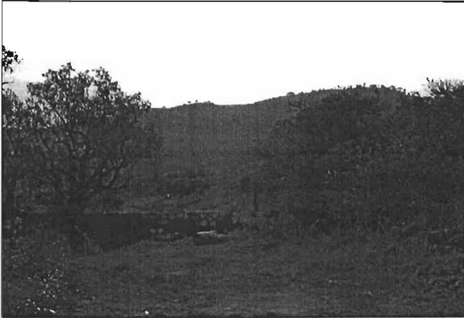
Vista de la represa que se ubica en la base del cerro Jaral
