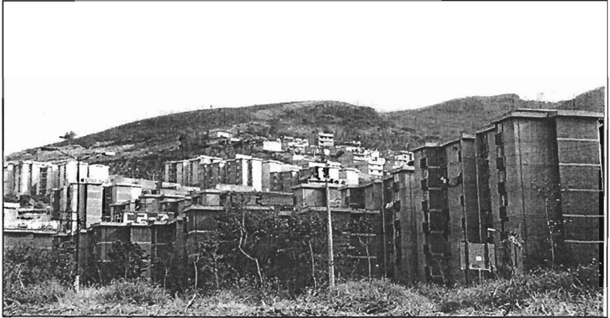
Lugar que puede ser afectado por volteo de bloques de roca. Vista SW del cerro Loma Bonita
