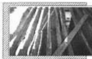
CUARTO QUE PRESENTA EN MAL ESTADO SU ENTREPISO, SE PUEDE APRECIAR EL ACORRUDO DE LAS VIGAS DE MADERA.
