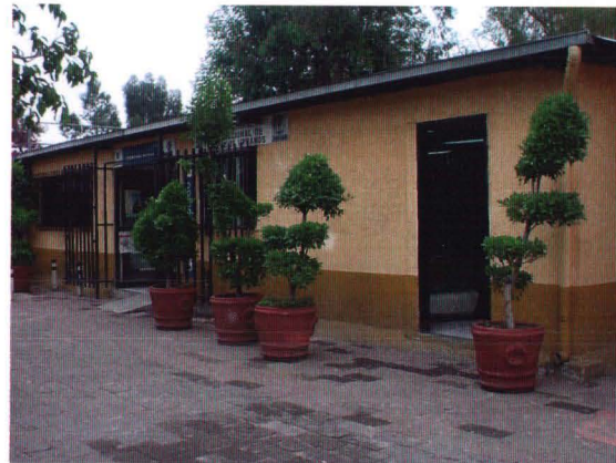
Ventanilla Única y CESAC ubicado en la calle Gladiolas N° 161 barrio de san Pedro a un costado del edificio delegacional.
