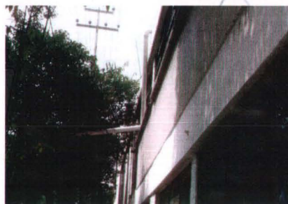
Instalaciones aparentes en fachadas.
