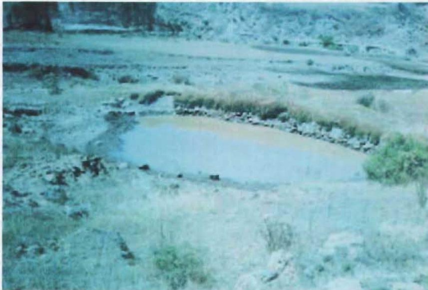
FOTO 4: Bordo construido por la población, aprovechando los escurrimientos de los arroyos intermitentes de la ladera norte del C. De Enmedio., al fondo se observa el área de erosión del C. Tecaxic. Autor: Sierra Domínguez G.
