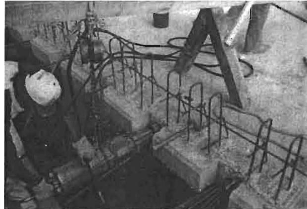
APLICACIÓN DE PREESFUERZO UNA VEZ QUE LA LOSA ALCANZO EL 80% DE SU RESISTENCIA.
