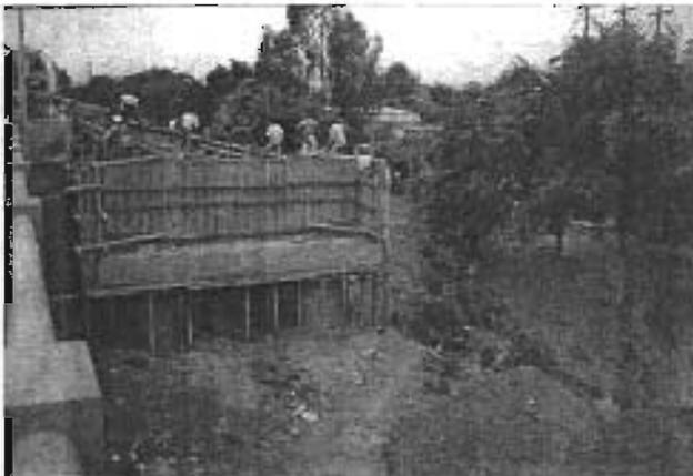
CABALLETE No. 1, EL CUAL SE TIENE CIMBRADO EL MURO DE RESPALDO Y PANTALLAS, ASI COMO ESTA APUNTALADO EL CABEZAL YA QUE AUN NO ALCANZA SUFICIENTE RESISTENCIA PARA LIBERARLO.
