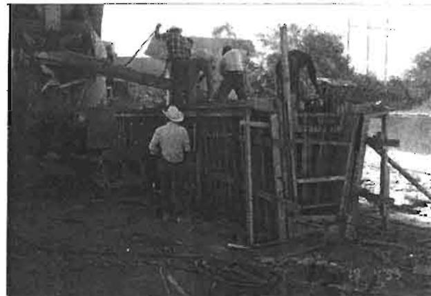
DETALLE DE LA CIMBRA SE PUEDE APRECIAR QUE YA ESTA COLOCADO EL ACERO DE PREESFUERZO DE LA PRIMER ETAPA.
