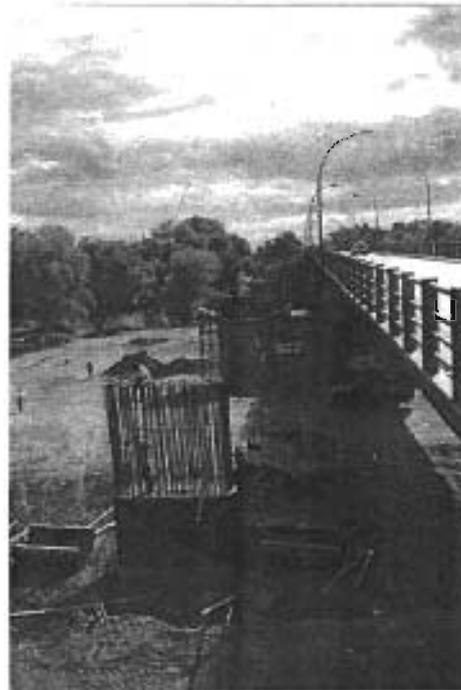
TOMA PANORÁMICA DONDE SE APRECIA DOS ETAPAS DISTINTAS DE LA PILA, EN LA PRIMERA SE ESTA CONSTRUYENDO EL CUERPO DE PILA Y EN LA OTRA EL CABEZAL.
