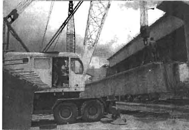
MANIOBRA DE MONTAJE PARA TRABE OPUESTA AL PUENTE EXISTENTE.
