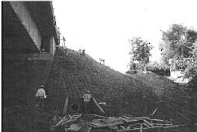
COLOCACIÓN DE MALLA ELECTRO SOLDADA PARA COLOCAR PROTECCIÓN DE CONCRETO AL CONO DE DERRAME.
