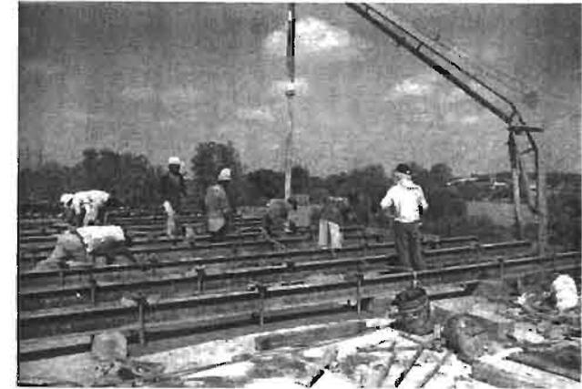
SISTEMA DE PISO PARA CIMBRADO DE LA LOSA.
