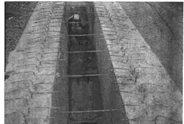
INYECTADO DE MORTERO A CABLES INTERIORES.
