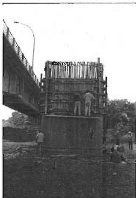
CIMBRADO DE UN TERCER TRAMO DEL CUERPO DE PILA.
