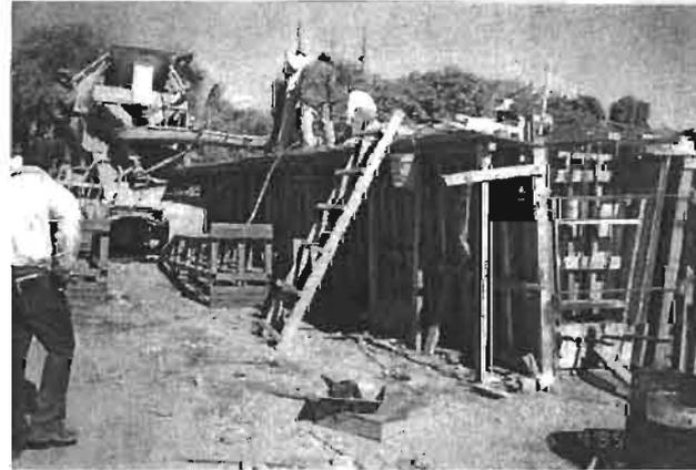
SUMINISTRO DEL CONCRETO, SE TUVO QUE AGREGAR UN ADITIVO FLUIDIFICANTE PARA PERMITIR QUE EL CONCRETO LLEGARA HASTA ABAJO DEL MURO DE LA TRABE.
