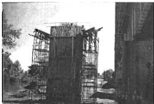
ARMADO DE ANDAMIOS QUE SOSTENDRAN LA CIMBRA PARA CONSTRUIR EL CABEZAL DE LA PILA.
