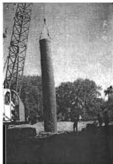
EN ESTA TOMA SE APRECIA EL ADEME METÁLICO DE 10 m DE LONGITUD QUE SE COLOCA PARA EVITAR DERRUMBES.
