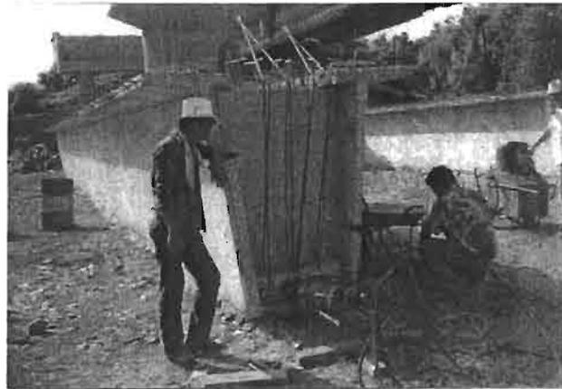
GATOS PARA CABLES DE 7 mm, VERIFICACIÓN DE LONGITUD DE ALARGAMIENTO Y MEDICIÓN DE PENETRACIÓN DE CONO, POR OTRO LADO SE PUEDE APRECIAR LA ZONA ESCARIFICADA PARA DIAFRAGMAS.
