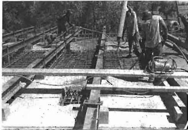
COLADO DE LOSA CENTRAL DONDE SE PUEDE APRECIA EL SISTEMA DE CIMBRA UTILIZADO.
