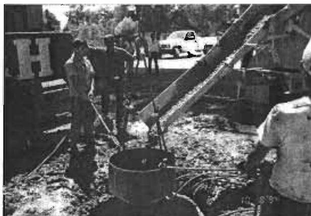
EMBUDO SUPERIOR DEL TUBO TREMI DONDE SE VACÍA EL CONCRETO.
