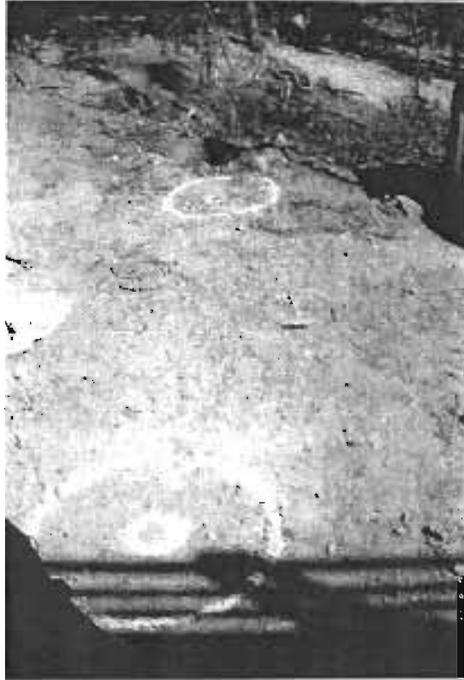
TRAZO DE LOS EJES DE LOS PILOTES PARA INDICAR EL PUNTO DE PERFORACIÓN.
