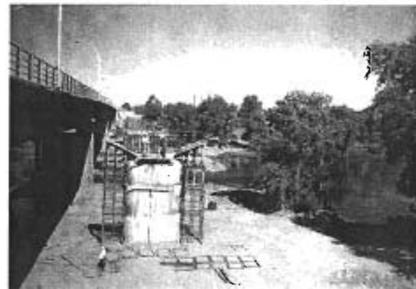
ARMADO DEL ACERO DE REFUERZO Y DE LA CIMBRA PARA HABILITAR EL CABEZAL, SE PUEDE APRECIAR LOS ANDAMIOS UTILIZADOS PARA LOS VOLADOS DEL CABEZAL
