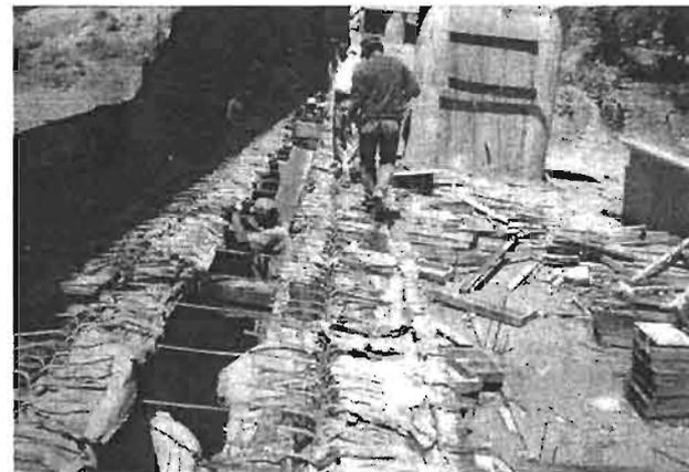
PARA EL CURADO DE LOS PATINES (ZONA EXPUESTA) SE COLOCO ARENA HÚMEDA Y SE CUBRIÓ CON CARTÓN PARA AYUDAR AL CONCRETO A NO PERDER HUMEDAD.
