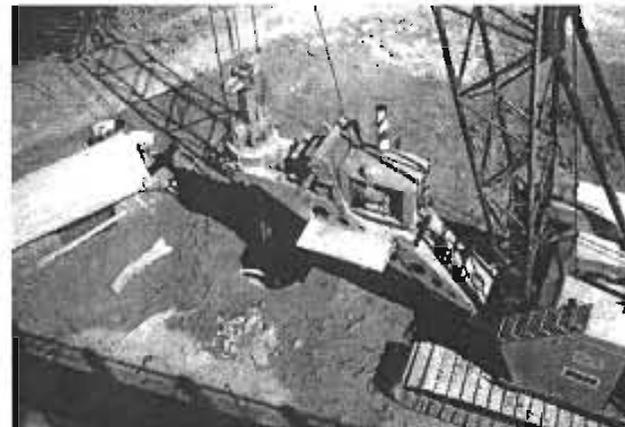
UNA VEZ ALINEADO VERTICALMENTE EL POSTE SE PROCEDE A INICIAR LA PERFORACIÓN, AQUÍ SE MUESTRA LA PERFORADORA YA MONTADA EN LA GRÚA.
