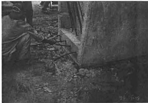
TERMINADO EL TENSADO SE PROCEDE A SELLAR CON CONCRETO LAS ZONAS DE ANCLAJE Y A INYECTAR A TRAVÉS DE LAS MANGUERAS MORTERO PARA PROTEGER CABLES.
