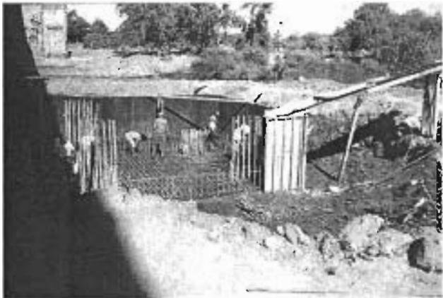
HABILITADO DE LA CIMBRA, ASÍ COMO ARMADO DEL ACERO DE REFUERZO, POR OTRO LADO SE MUESTRA LA BANDA PARA EL COLADO.
