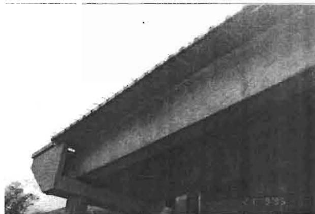
UNA VEZ QUE SE APLICÓ TENSIÓN EN LOS CABLES DE PREESFUERZO SE PROTEGEN LOS SELLOS MEDIANTE CONCRETO Y SE INYECTA LECHADA PARA DAR PROTECCIÓN A LOS CABLES.
