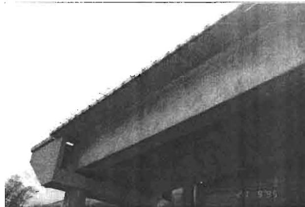
UNA VEZ QUE SE APLICO TENSIÓN EN LOS CABLES DE PREESFUERZO SE PROTEGEN LOS SELLOS MEDIANTE CONCRETO Y SE INYECTA LECHADA PARA DAR PROTECCIÓN A LOS CABLES.
