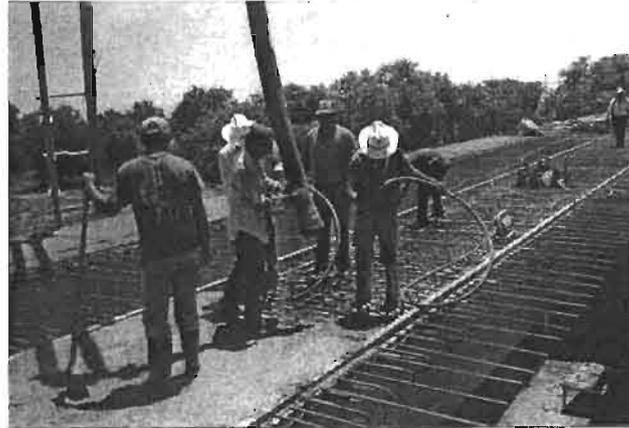
EL COLADO SE REALIZO MEDIANTE UNA PLUMA BOMBA PARA CONCRETO, SE PROCURA DEJAR UN TERMINADO RUGOSO.
