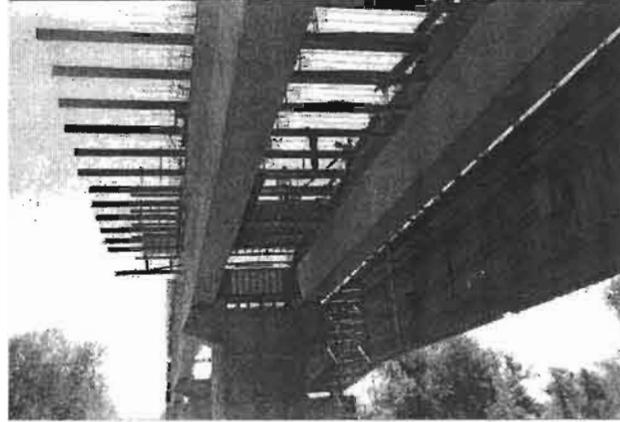
COLOCACIÓN DE IPRS PARA COLOCAR SISTEMA DE PISO PARA CIMBRA Y EL CIMBRADO DE DIAFRAGMA.
