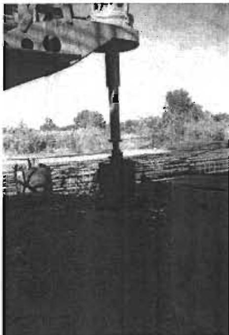
BOTE CON EL QUE SE EXTRAER EL MATERIAL PRODUCTO DE LA PERFORACIÓN.
