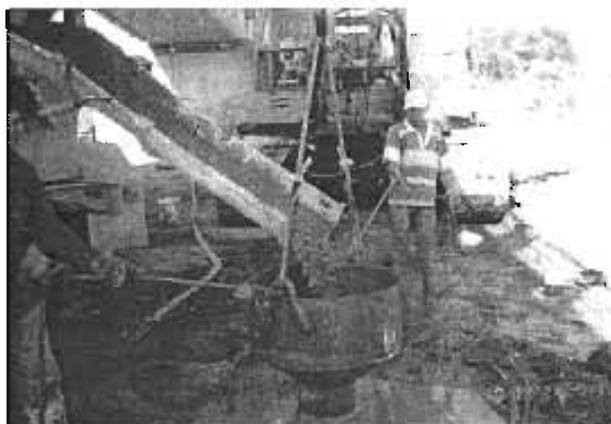
VACIADO DE CONCRETO EN EL TUBO TREMI.
