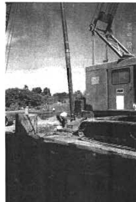
ARMADO DEL TUBO TREMI, EL CUAL SE UTILIZA PARA HACER LLEGAR EL CONCRETO HASTA EL NIVEL INFERIOR DE LA PERFORACIÓN EVITANDO LA DISGREGACIÓN.
