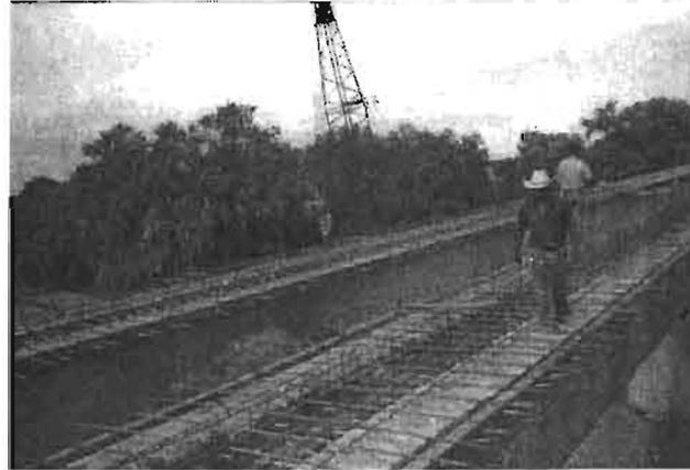
CIMBRADO ARMADO DEL ACERO DE REFUERZO PARA LA LOSA TAPA DE LA TRABE, ANTES DEL CIMBRADO SE COLOCA LOS DUCTOS Y EL ACERO DE PREESFUERZO DE LA SEGUNDA ETAPA EN TRABES.
