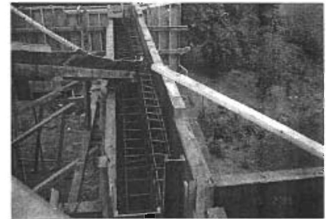
CABALLETE No. 1 EN EL QUE ESTA CIMBRADO EL MURO DE RESPALDO, SE PUEDEN APRECIAR LAS VARILLAS DE LA MENSULA PARA LA LOSA DE ACCESO.
