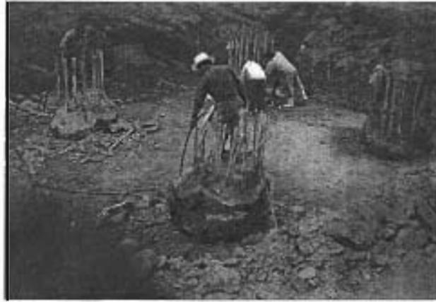
DEMOLICIÓN DE PILAS DE CIMENTACIÓN PARA RETIRAR EL CONCRETO CONTAMINADO CON BENTONITA.
