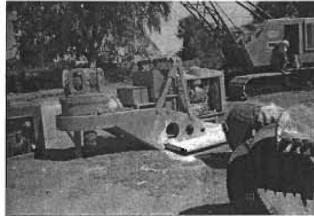
EQUIPO DE ROTACIÓN PARA PERFORACIÓN WATSON EL CUAL SE MONTA EN UNA GRÚA.
