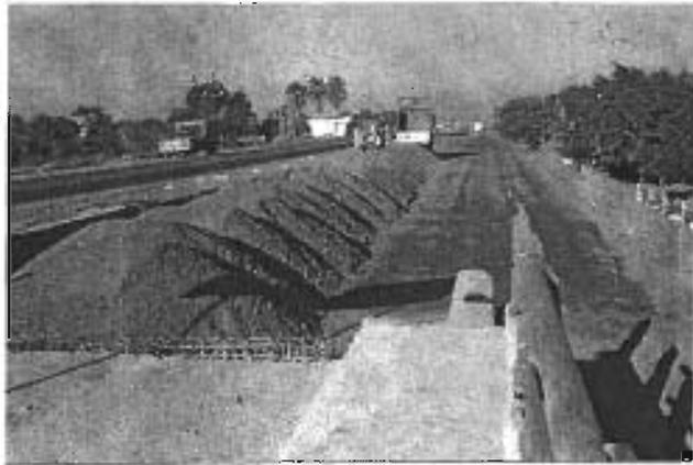
ZONA DE TERRAPLÉN DE ACCESO EN EL QUE SE TIENE MATERIAL LISTO PARA SER EXTENDIDO Y POSTERIORMENTE COMPACTADO.
