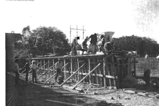
EL VIBRADO SE REALIZO DE MANERA CUIDADOSA PARA NO PERMITIR BOLSAS DE AIRE EN LOS MUROS Y SOBRE TODO QUE NO TUVIERA DISGREGACIÓN EL CONCRETO.
