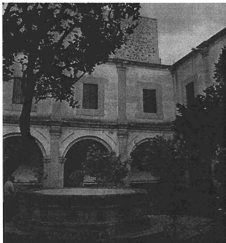
Patio de los naranjos. La división del ducto en la plaza del acueducto, permitía la alimentación de esta fuente en el centro del patio de los naranjos antiguo noviciado, después de alimentar la fuente, un canal subterráneo salía en dirección oriente hacia la huerta pasando por debajo del poyo localizado en la puerta a la huerta y ya en esta, se incorporaba a los canales de riego, (el oriente en la fotografía es la zona desde la que se hizo la toma).
