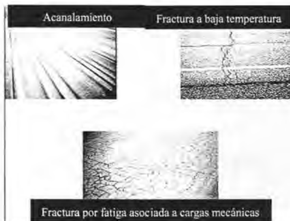
FIGURA 1.5. Fallas originadas en pavimentos asfálticos
