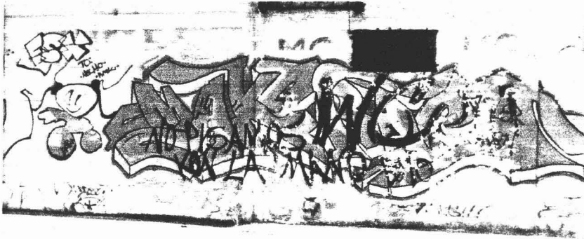
13. Avenida Prados de Aragón 12 04 04.
