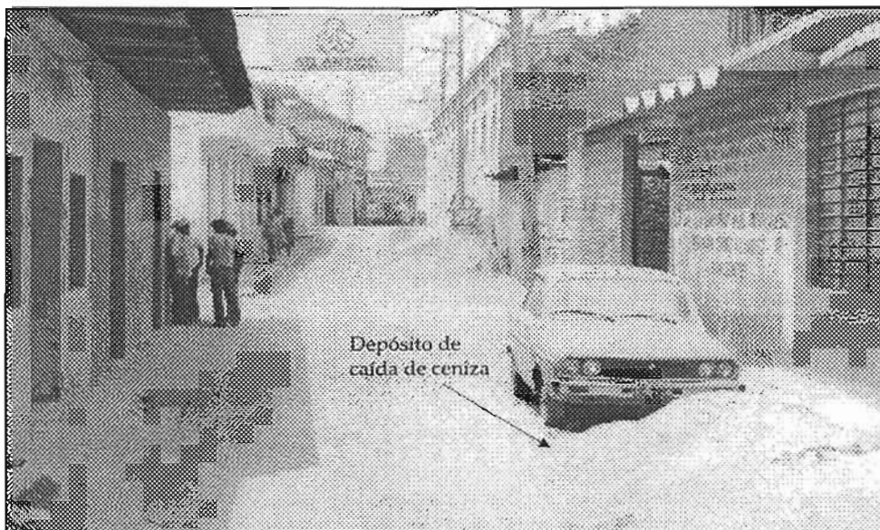
Figura 2.5 Efecto de la ceniza que cayó a 20 km del cráter en la ciudad de Pichucalco, Chiapas, durante la erupción de 1982 del volcán Chichón. Se aprecian los daños causados a las calles e infraestructura. Fotografía: Federico Fregoso, abril 1982.
