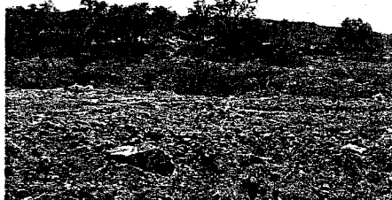
SE OBSERVA EL TIPO DE MATERIAL DE RELLENO, QUE FUE COLOCADO A VOLTEO.
