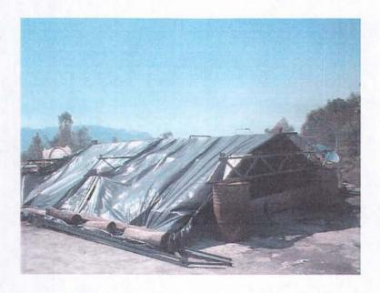
Protección de las inclemencias del tiempo con armazón metálico y cubierta de plástico
