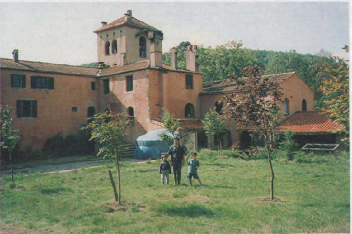
FOTO 1: La Borie Noble. Edificio principal Languedoc, Francia.
