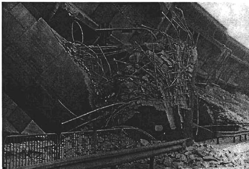
**Figura 2.4 Falla flexo-cortante debido al corte prematuro del refuerzo longitudinal, casi a la mitad de la altura de la columna**
