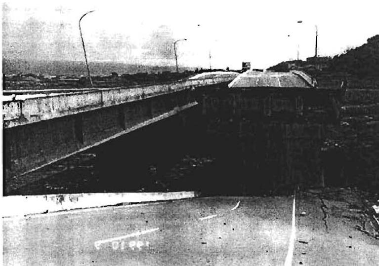
*Figura 2.8 Falla de la cubierta de un puente durante el sismo de Chi Chi en 1999*
