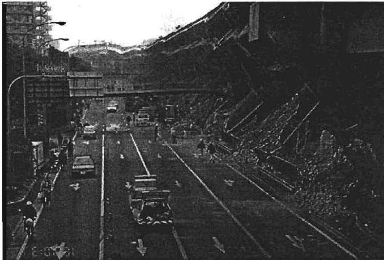
*Figura 2.1 Colapso del puente Hanshin durante el sismo de Kobe en 1995*
