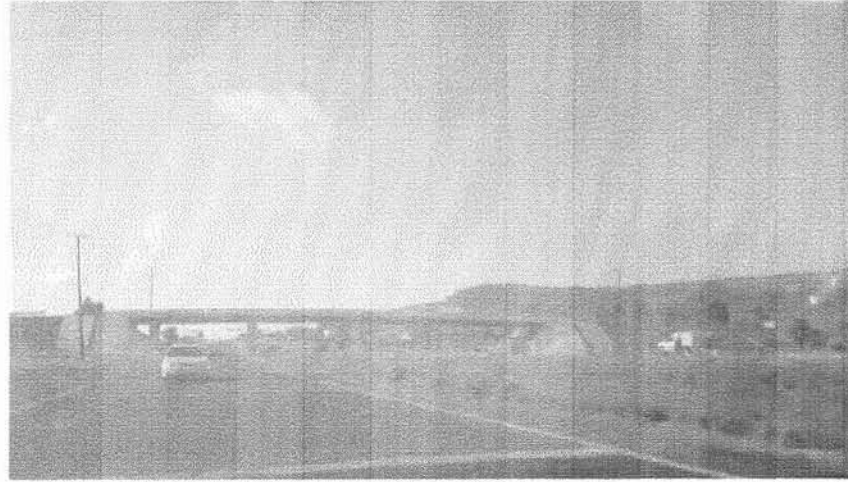
IMAGEN DE AUTOPISTA QUERÉTARO-CELAYA
