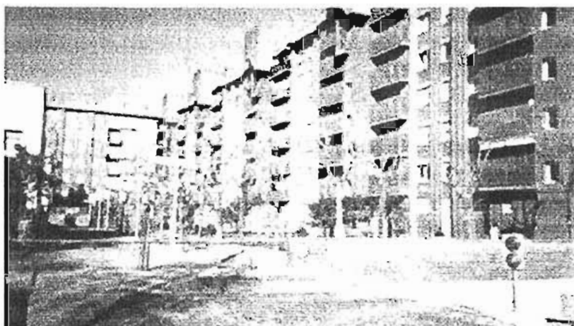
Fig. 3.4. Panorámica de un Conjunto Habitacional
