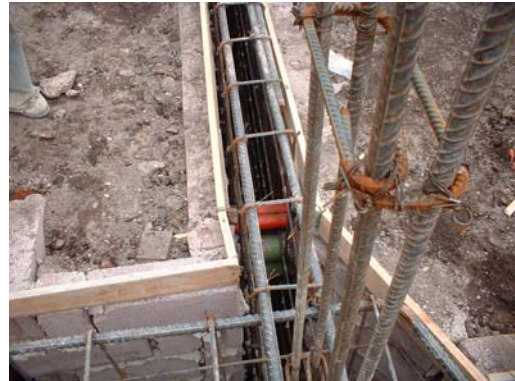
Vista general de cimentación, contratrabes, dados, columnas y castillos previamente anclados, tubería para instalaciones y plantilla de concreto simple todo listo para recibir la losa de cimentación.
