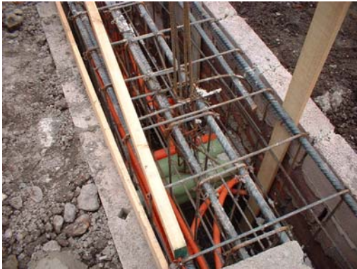
Vista general de cimentación, contratrabes, dados, columnas y castillos previamente anclados, tubería para instalaciones y plantilla de concreto simple todo listo para recibir la losa de cimentación.
