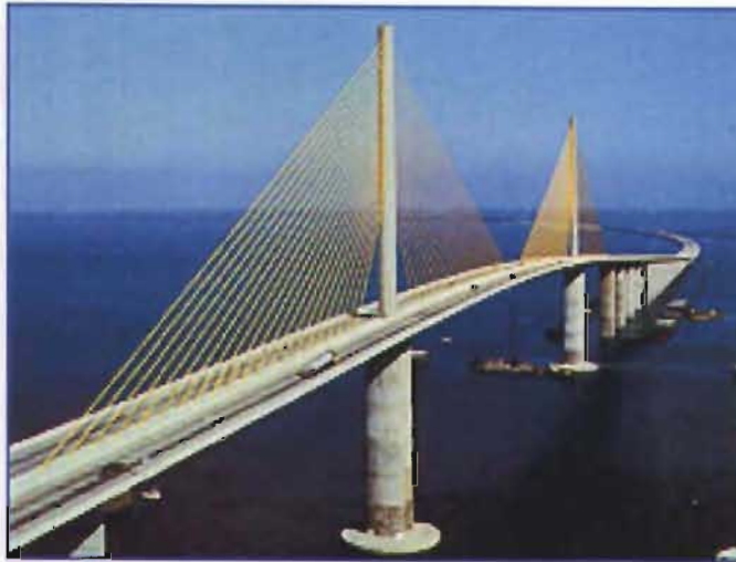
Fig. 1-34 Sunshine Skyway Bridge , Estados Unidos [Ref. B-14].
