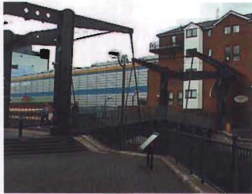
Fig. 1-14 Puente con elevación vertical [Ref. B-18].
