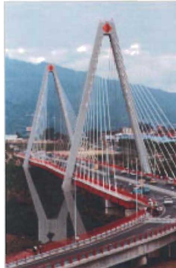
Fig. 1-45 Viaducto con torres tipo diamante, Venezuela [Ref. B-21].
