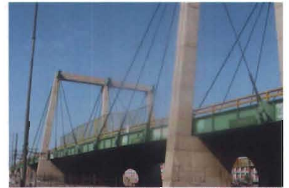
Fig. 1-38 Viaducto, México, D.F. 31 Foto. M. Espinosa, 2003.
