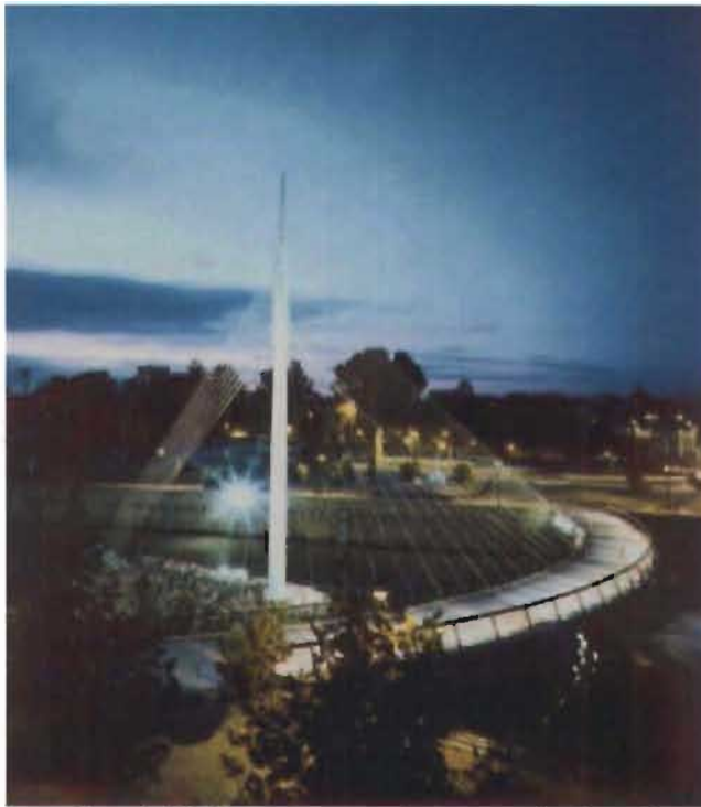
Fig. 1-41 Puente peatonal con arreglo de cables espacial. Malecón, España [Ref. B-21].
