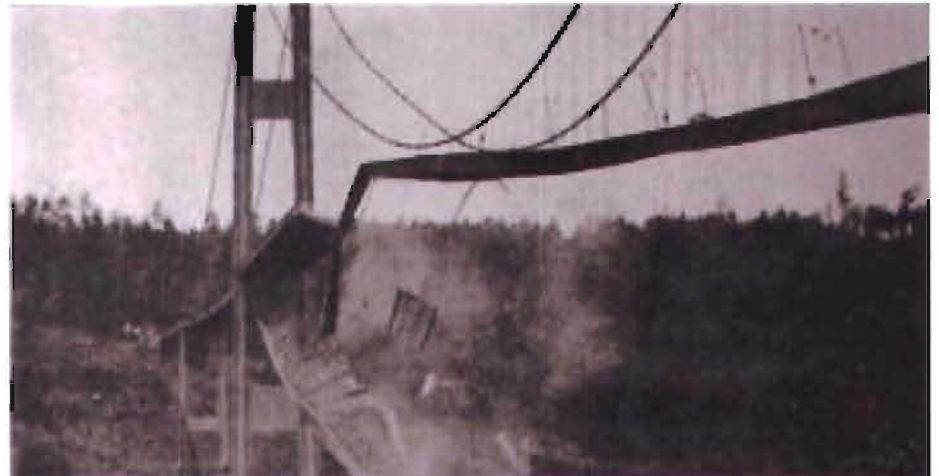
Fig. 1-31 Puente Tacoma Narrows , Estados Unidos, [Ref. B-16].
