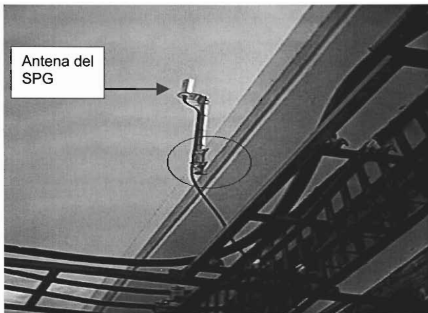
Figura 4.20. Instalación de la antena del SPG.
