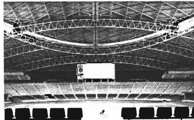
FIG. 02 Vista de la cubierta del estadio de Fútbol Oita.
