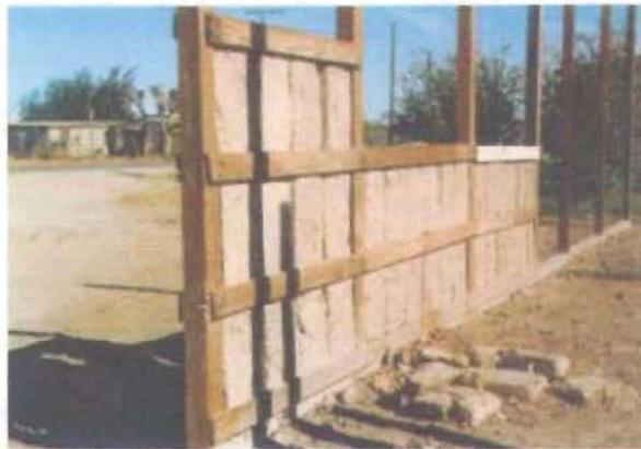
Técnica que consiste en que las piezas de adobe sirven de relleno de un entramado de madera. El cual forma parte del muro de la construcción
