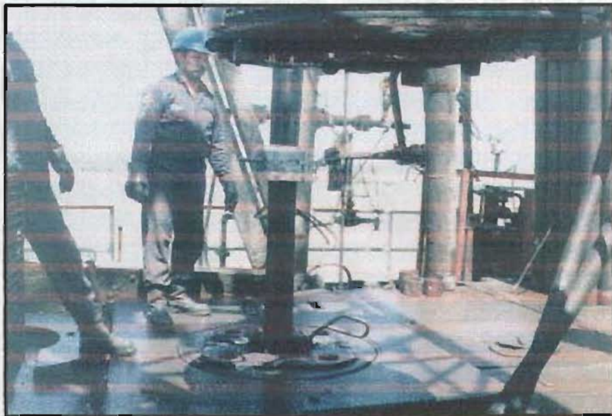
Figura 3.21 Buscando reducir el tiempo en la conexión, se implementaron algunos accesorios, en los que destaca el uso de la guía de enchufe.
