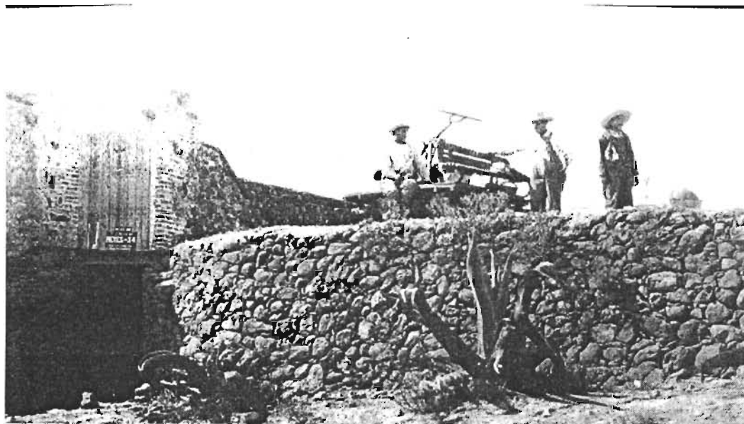
VIAS DECAUVILLE Y ARMON AL EXTERIOR DE LA HACIENDA DE REYES EN HIDALGO
