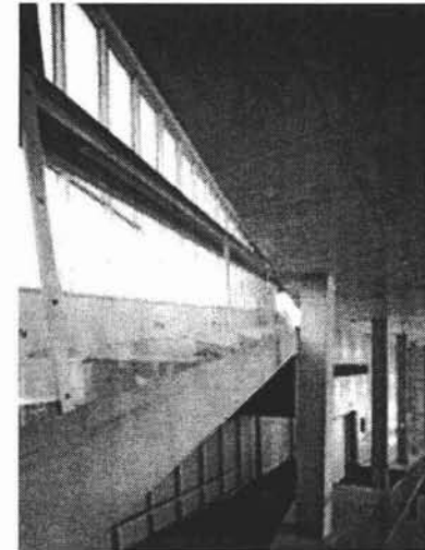
imágenes de las rampas que comunican el vestíbulo y las galerías
