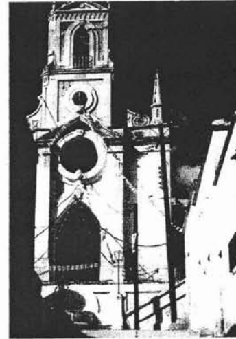
foto de la fachada
