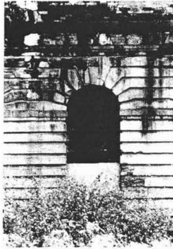
detalle de ventana
