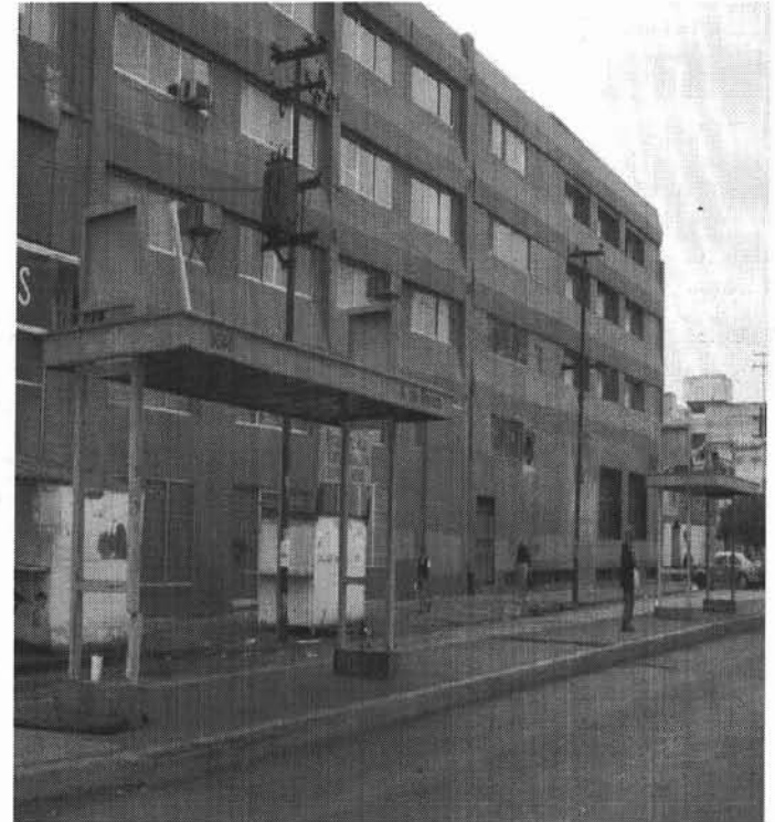
PARADERO DE AUTOBUSES EN ARCOS DE BELEN.
