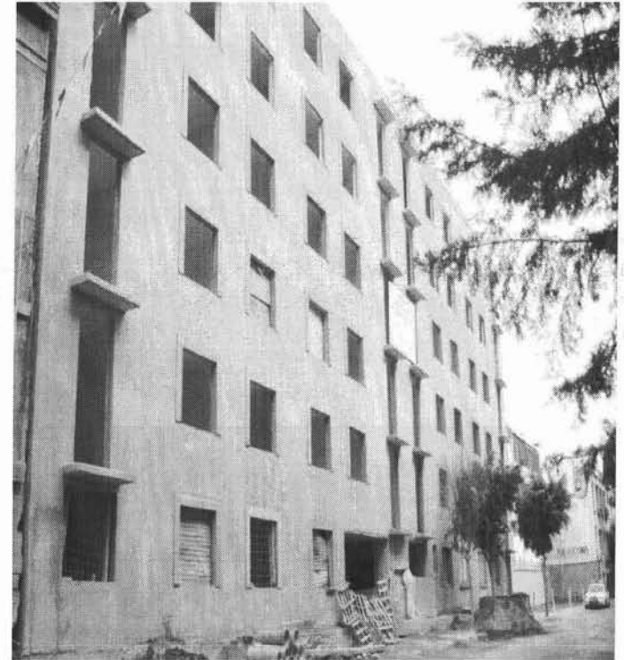
EDIFICIO DE VIVIENDA EN CONSTRUCCIÓN EN CALLE REVILLAGIGEDO.
