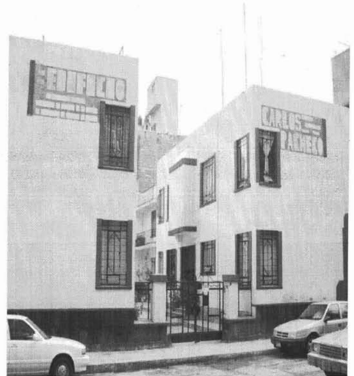
EDIFICIO CARLOS PACHECO.
