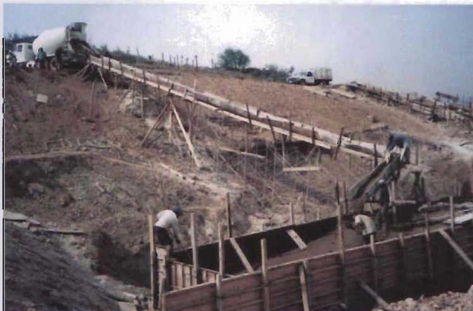
Figura 5.36 Descarga de suelo cemento fluido de camión revolvente para colado de muro por medio de canales de madera.
