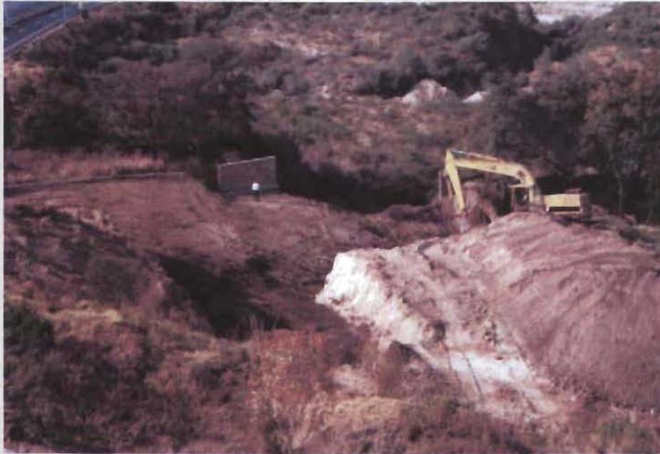
Figura 5.10 Excavadora realizando desmonte y despalme para excavación.
