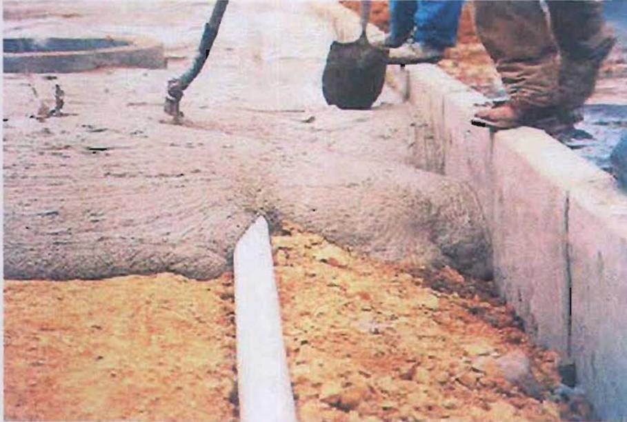
Figura 3.8. Suelo cemento fluido aplicado para nivelación del terreno en un camellón que tiene tubería de la red de agua potable.
