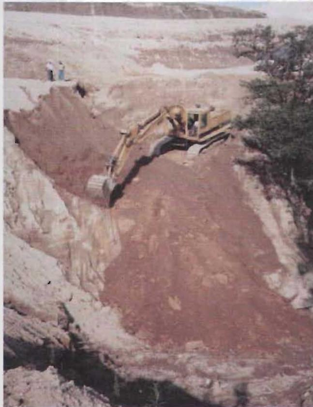
Figura 5.11 Excavadora abriendo paso para despallar y desalojar material suelto de la cañada.
