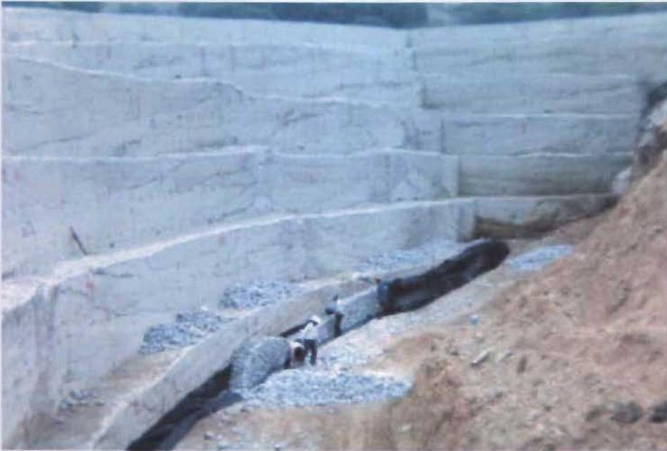
Figura 5.29 Colocación de filtro en el respaldo del muro.
