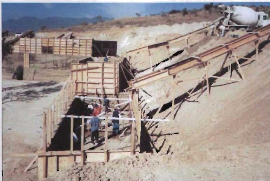
Figura 5.24 Colocación de tubos de PVC para dren en un nivel o bloque de muro establecido.
