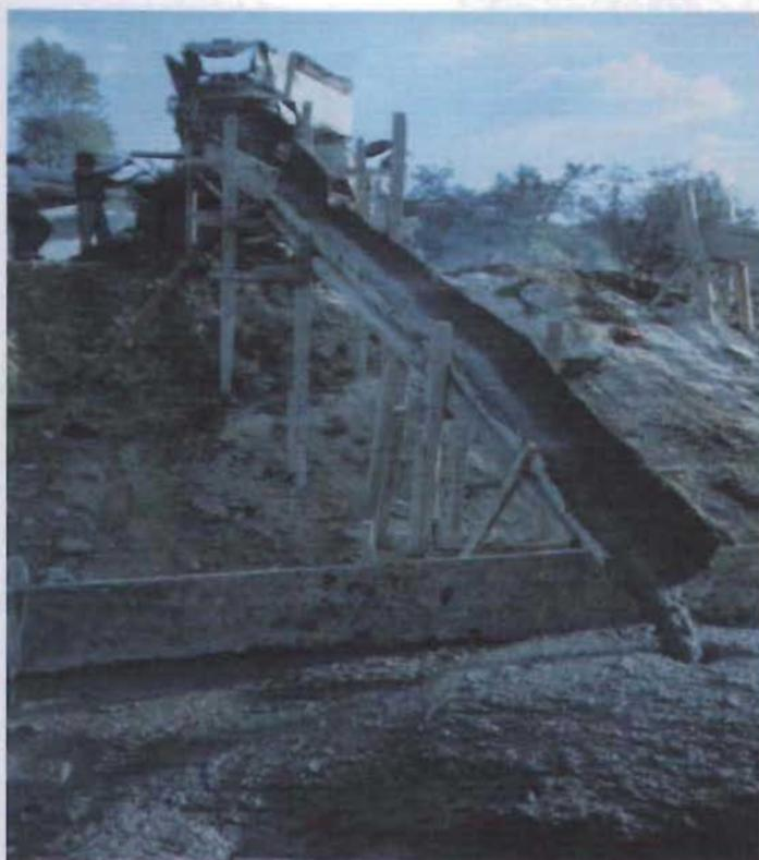
Figura 5.35 Descarga de suelo cemento fluido de camión agitador para colado por medio de canales de lámina.
