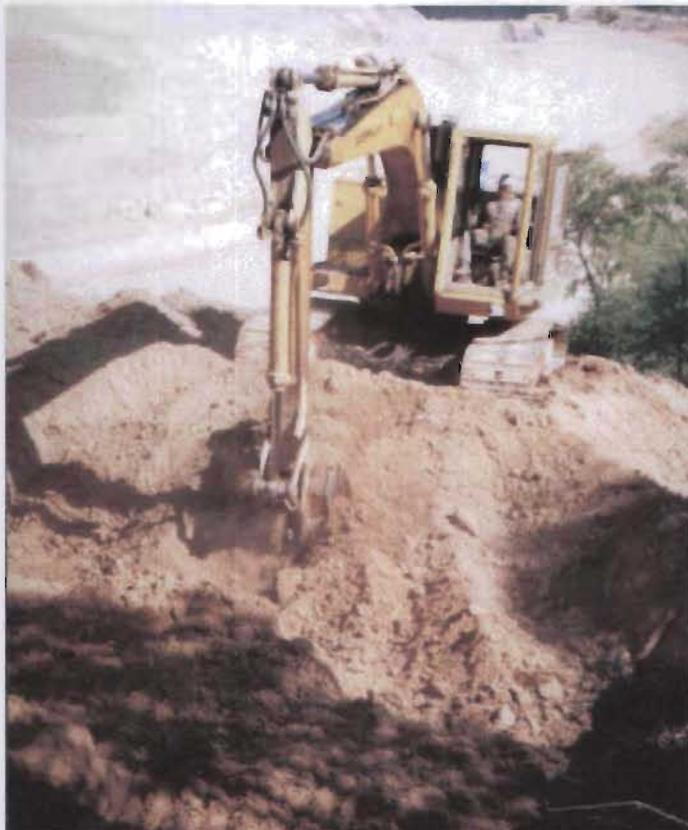
Figura 5.13 Inicio de excavación para la formación de plataformas para desplante de muro con excavadora.
