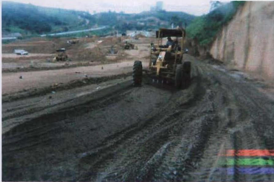
Figura 3.5 Estabilización de material granular para base por medios mecánicos.
