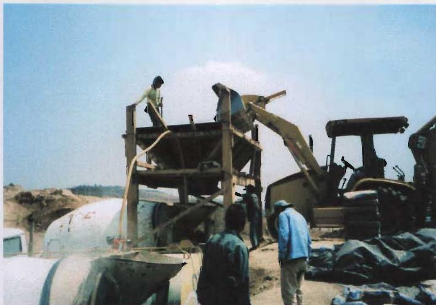
Figura 2.2 Elaboración de suelo cemento fluido en obra, con camión revolvedor.
