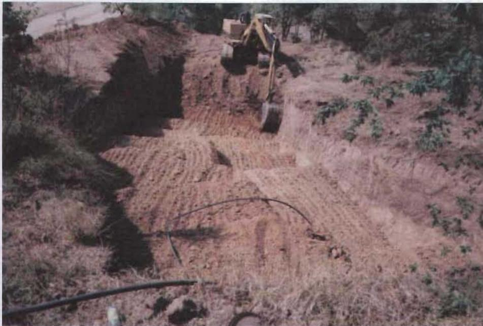
Figura 5.15 Plataformas a diversos niveles para desplante de muro.
