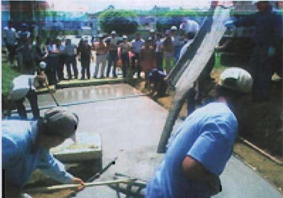
Figura 3.6 Formación de una base con suelo cemento fluido.
