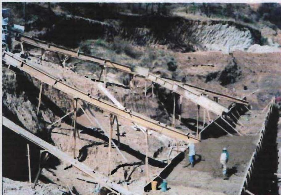
Figura 5.39 Descarga de suelo cemento fluido y extendido para nivelación de escalón con ayudantes.
