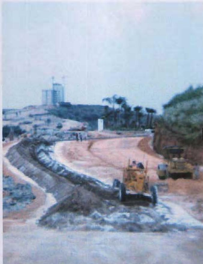
Figura 3.4 Estabilización de material granular para subbase por medios químicos.
