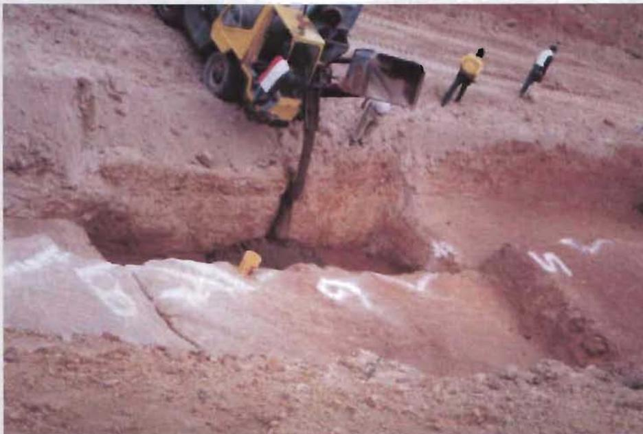
Figura 5.34 Descarga de suelo cemento fluido a tiro libre con olla revolvedora autocargable para colado.
