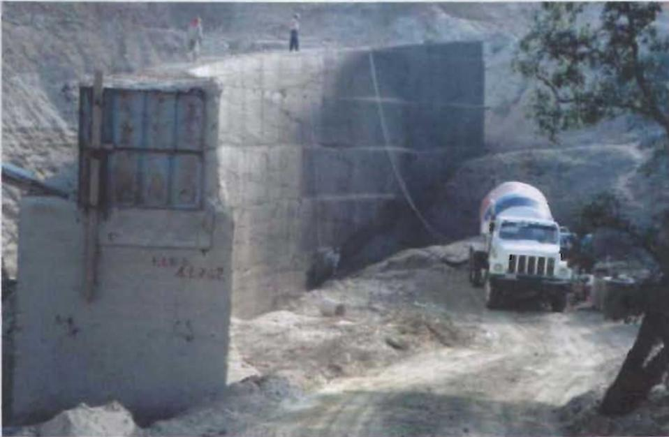
Figura 5.44 Paramento del muro de contención completamente con malla electrosoldada y listo para recibir concreto lanzado.
