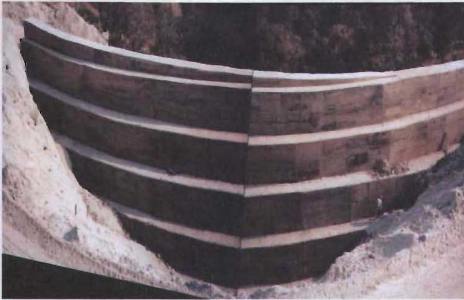
Figura 5.42 Muro de contención colado completamente hasta su corona.
