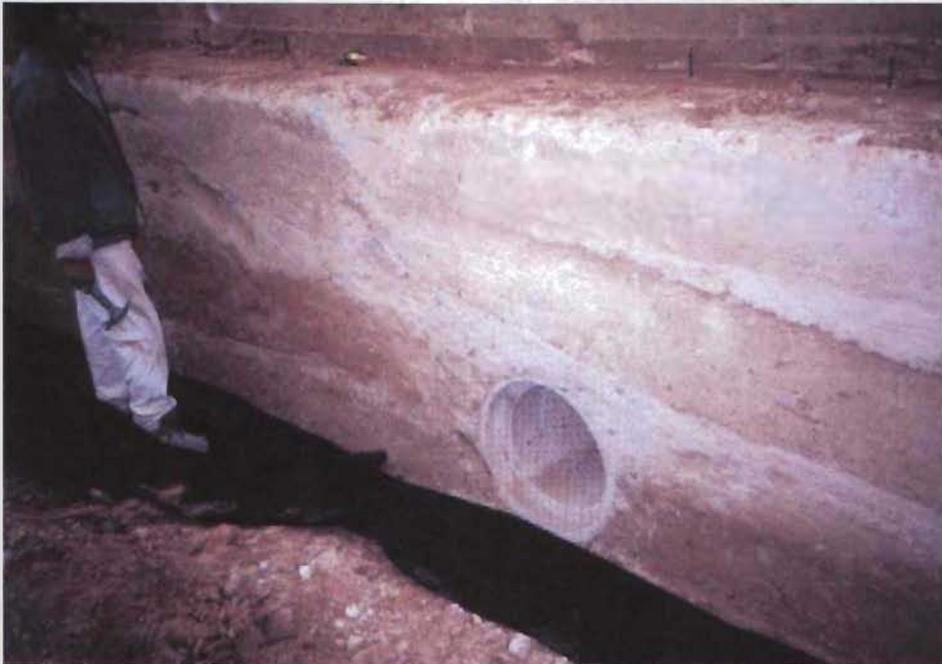
Figura 5.27 Preparación de geotextil para protección del filtro.
