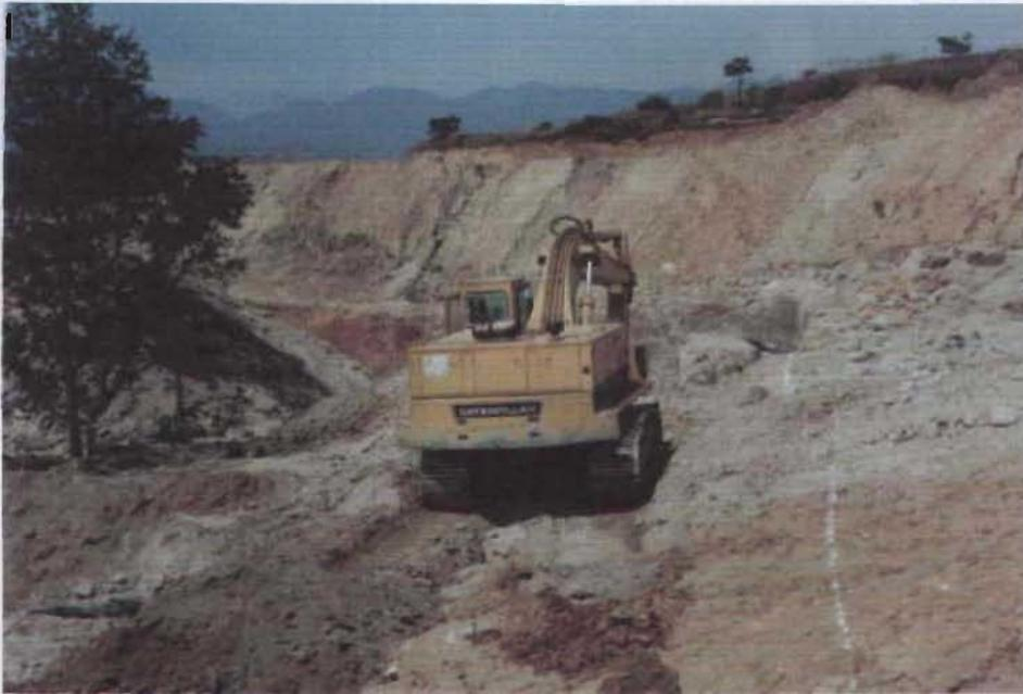
Figura 5.14 Excavación para la formación de plataformas en terreno con poca pendiente.
