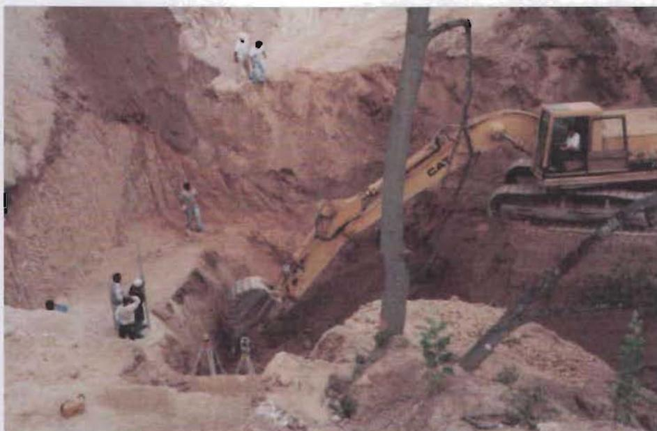
Figura 5.9 Colocación de nivel para desplante de muro en suelo firme.
