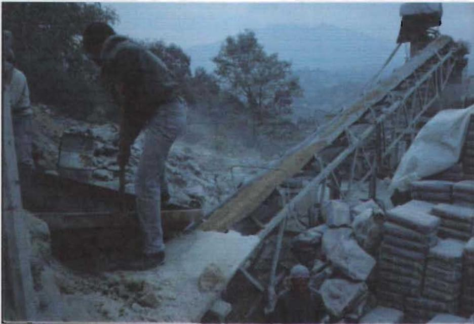
a) Suministro de agregado y cemento para la preparación de suelo cemento fluido
