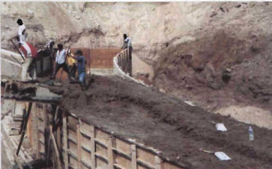
Figura 5.41 Superficie del escalón del muro rugosa con apoyo de un jalador.
