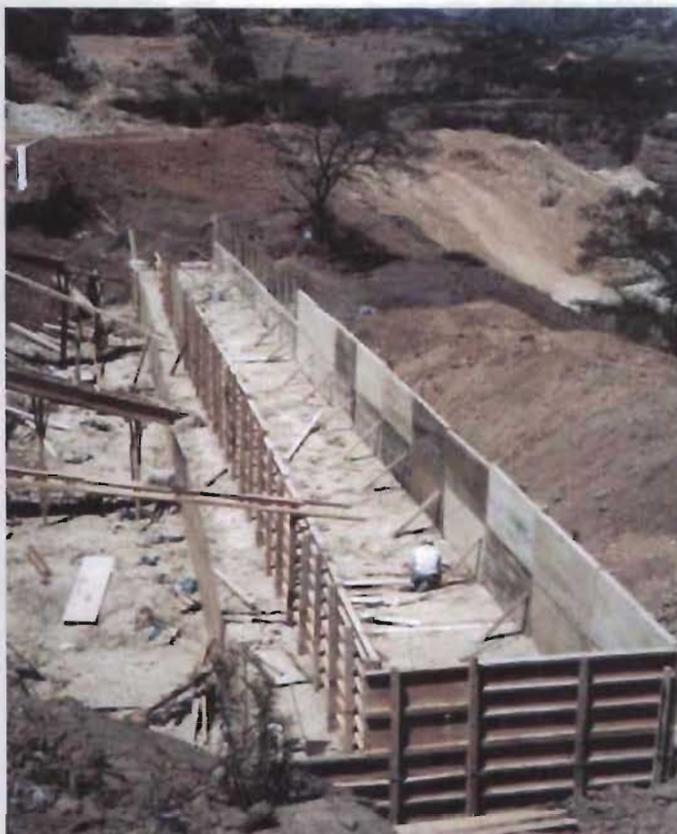
Figura 5.25 Excavación para colocar tubos de PVC con la pendiente de  $-2\%$ .
