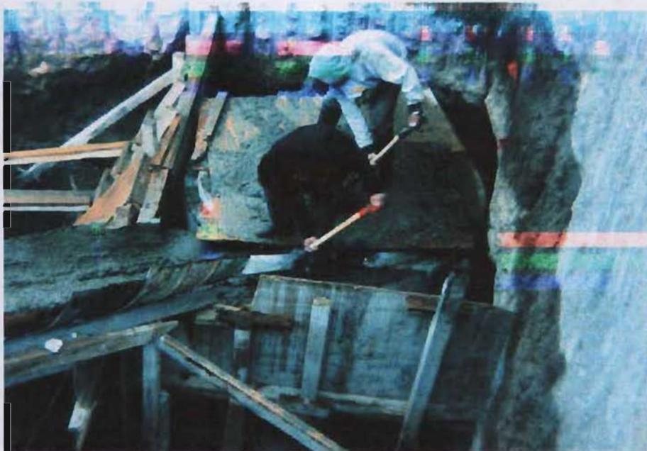
Figura 3.3 Relleno de la boca de una caverna con suelo cemento fluido, con acceso a su interior.
