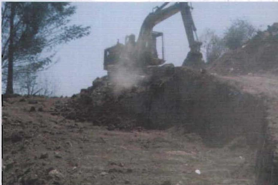
Figura 5.12 Despalle al inicio de la zona de trazo para muro.
