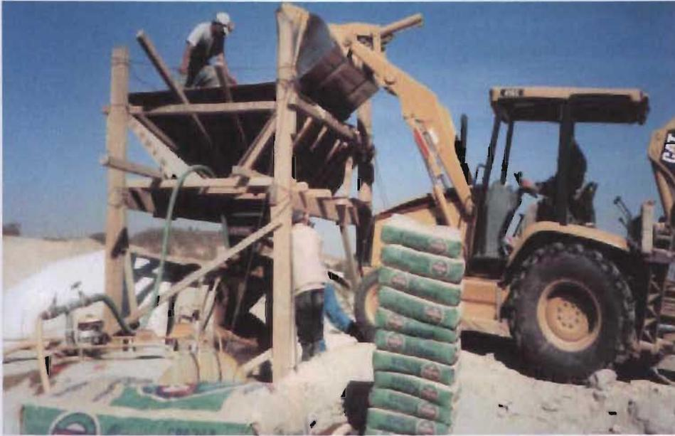
a) Alimentación de agregado en camión revolvedor con retroexcavadora
