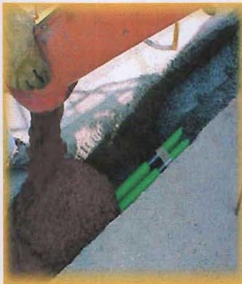
Figura 3.12 Suelo cemento fluido aplicado a una zanja con tubería.
