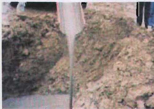
Figura 3.9 Nivelación de un terreno con suelo cemento fluido.
