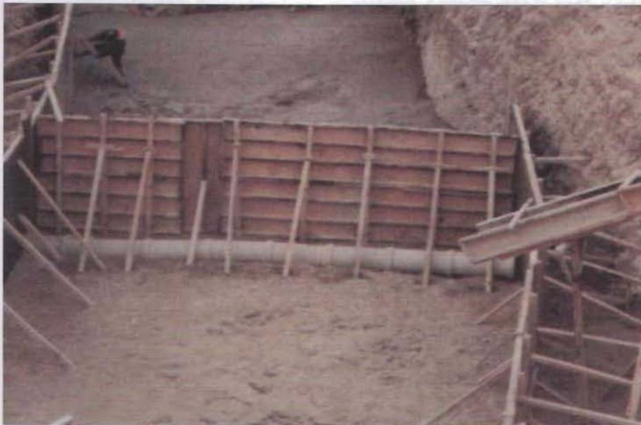
Figura 5.22 Tubo de albañal colocado para dren.
