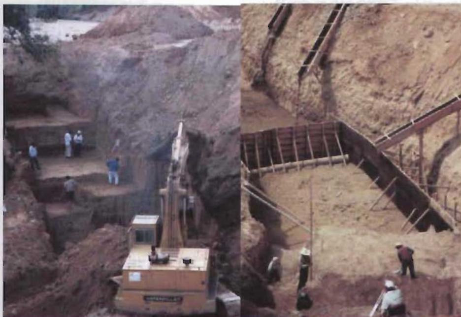
Figura 5.17 Retiro de material suelto de plataformas con personal.
