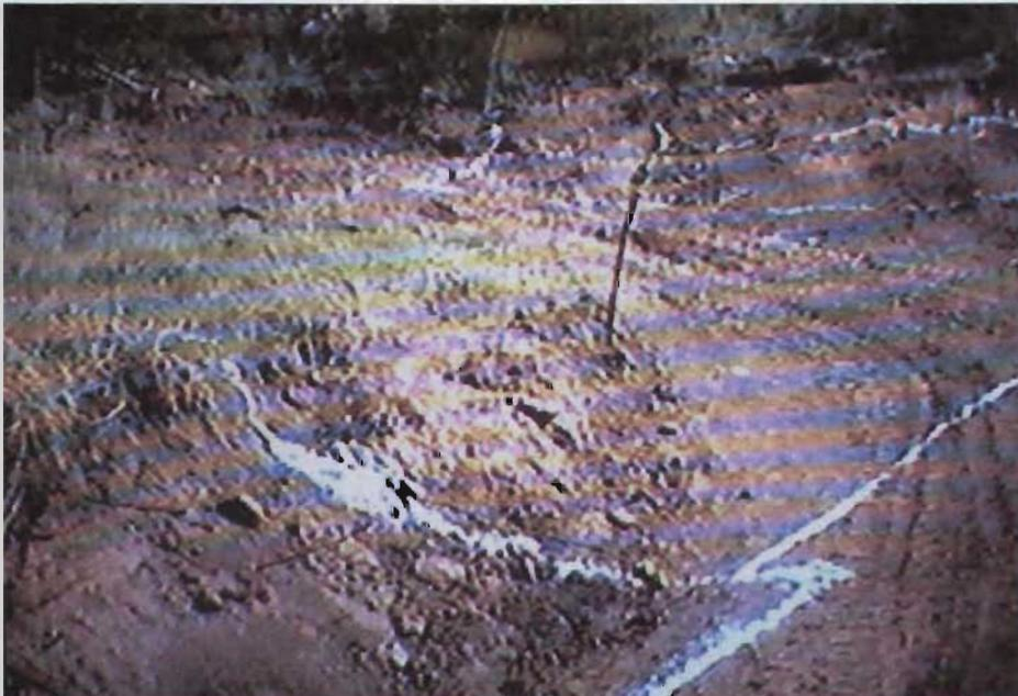
Figura 5.6 Trazo del área con líneas de cal para iniciar los trabajos de despálme.
