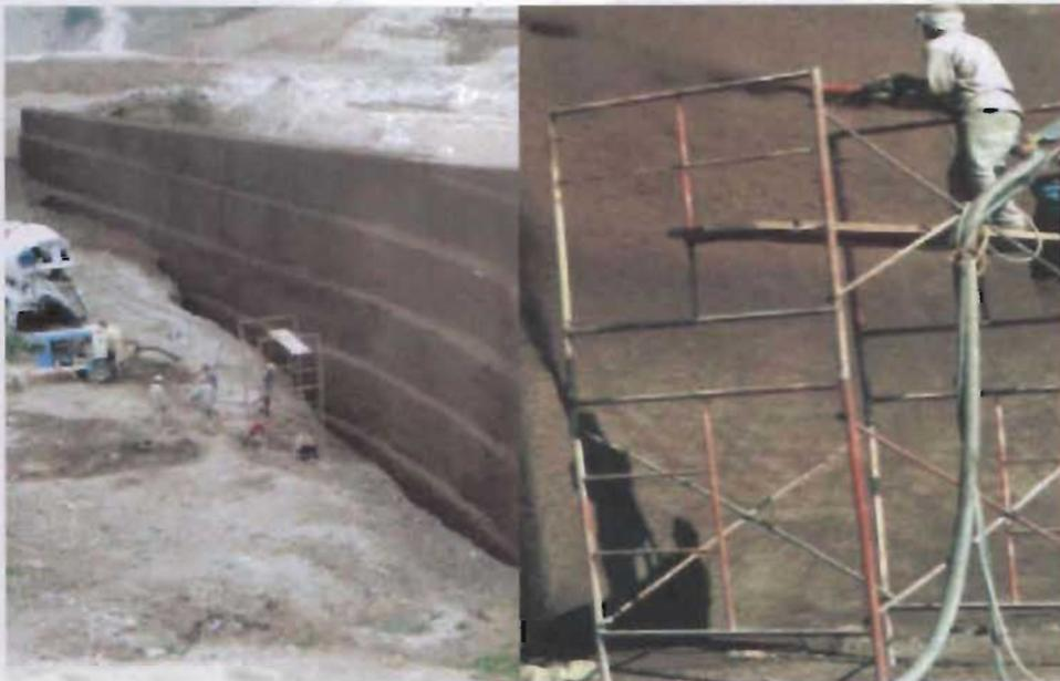
Figura 5.45 Lanzado de concreto sobre el muro de contención.
