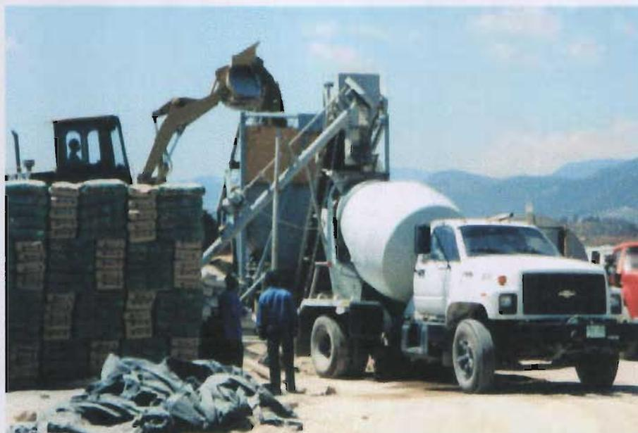
Figura 2.3 Elaboración de suelo cemento fluido en obra, con planta.
