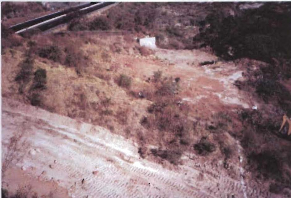
Figura 5.7 Eje de trazo con línea de cal y estacas del área donde se construirá un muro.
