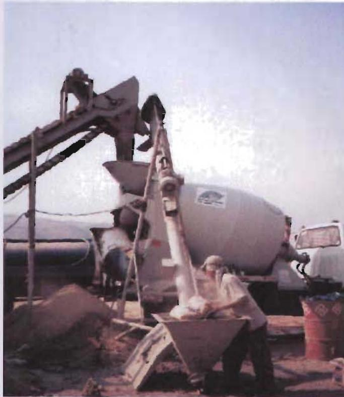
a) Suministro de cemento para la preparación de suelo cemento fluido
