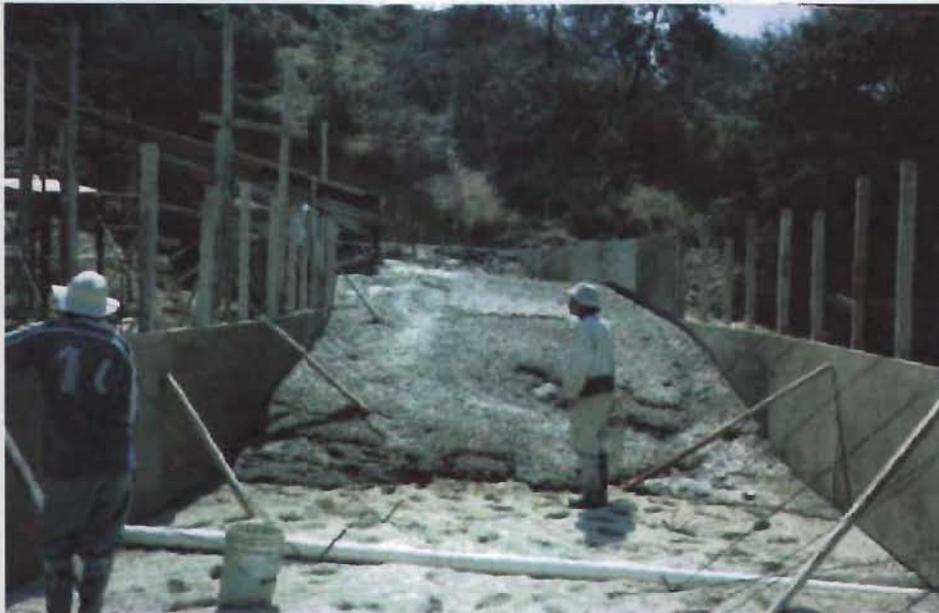
Figura 5.37 Desplazamiento del suelo cemento fluido.
