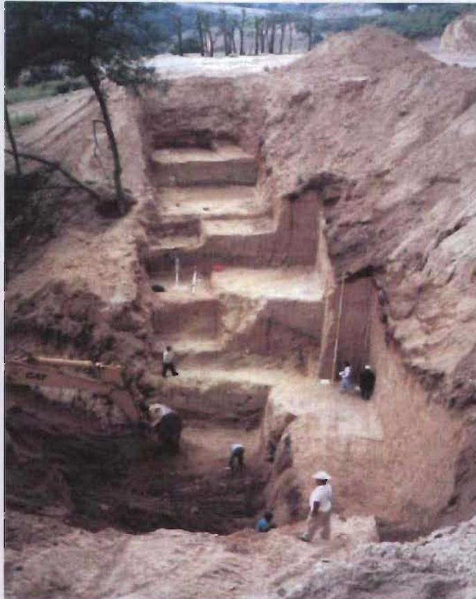
Figura 5.16 Desalajo de material suelto de la cañada y plataformas con contrapendiente.
