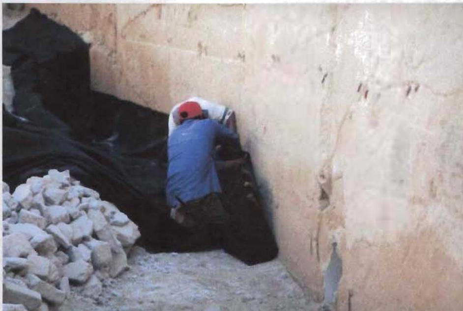
Figura 5.28 Colocación de geotextil clavado al muro para colocar el filtro.
