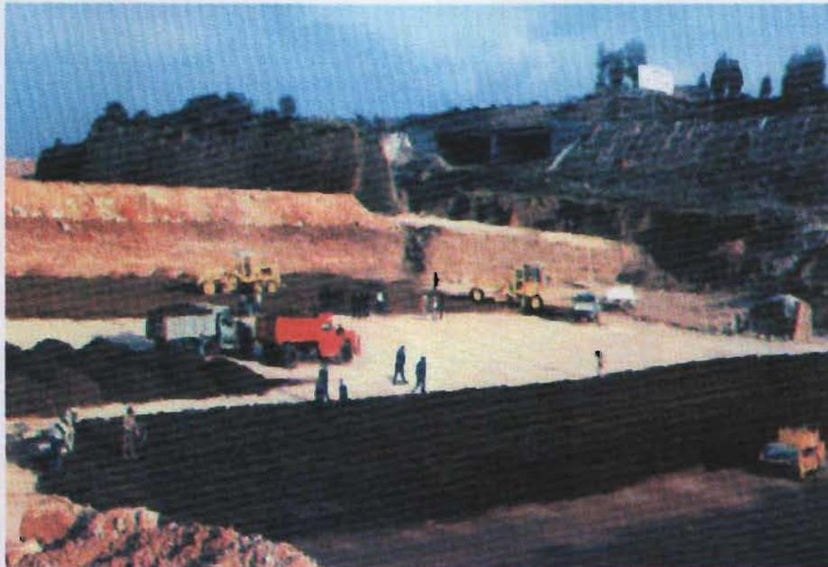
Figura 2.4 Colocación de suelo y cemento para formar la mezcla de suelo cemento con motoconformadora y compactador (De la Fuente, 1995).
