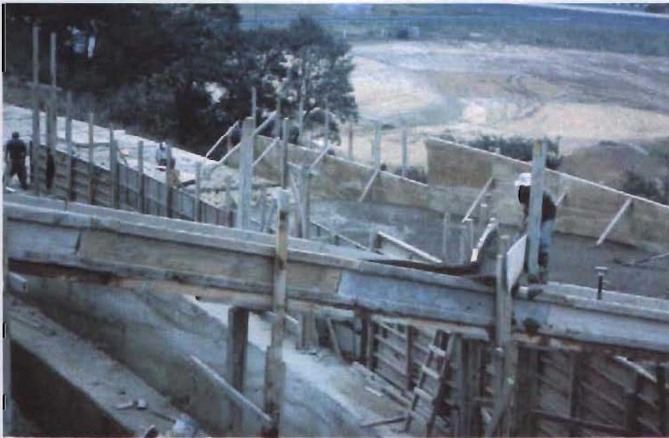
Figura 5.20 Escalones horizontales sucesivos y colocación de cimbra al mismo nivel para formar un bloque del muro.
