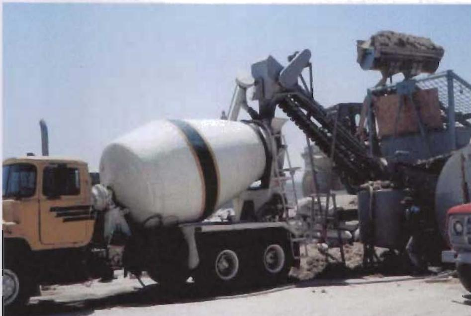
b) Suministro de agregados a la olla del camión revolvedor
