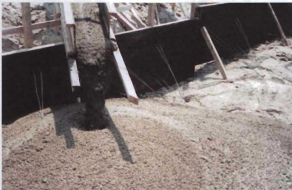
Figura 5.21 Cimbra de madera colocada al paño vertical del terreno que funge como cimbra para alcanzar en nivel requerido.
