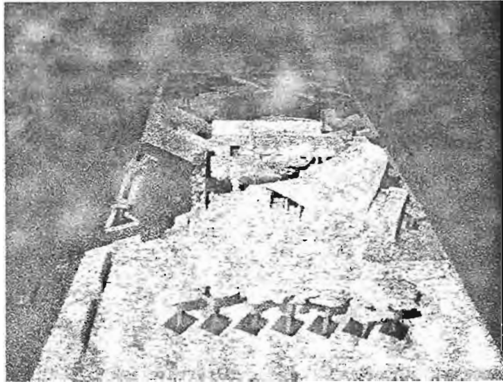
Vista aérea de conjunto, sureste.
