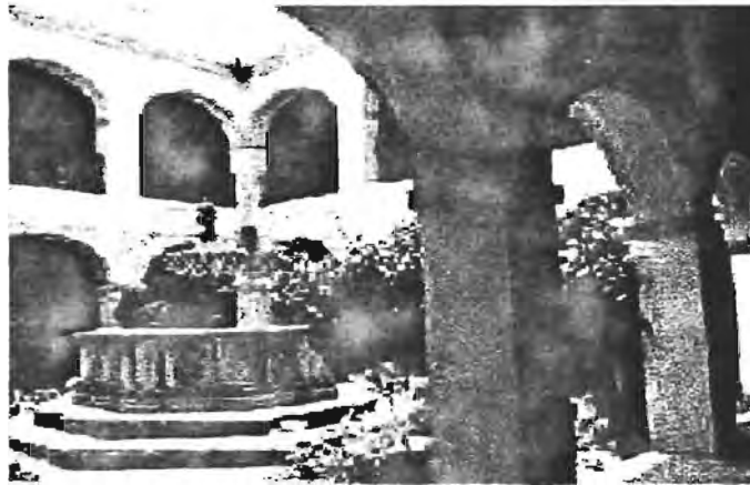
CONVENTO DE LA CRUZ, interior, vista de patio central, Querétaro. México.
