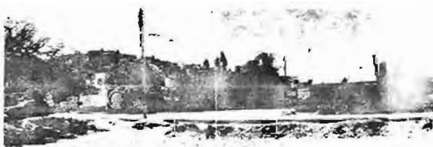
Calle Tlaxcala esquina con calle Guerrero, vista desde el interior del terreno.
