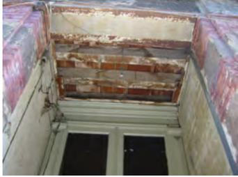
Oxidación de par galvánico en acero de soporte
