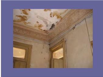
El encontrar manchas en los plafones indica que existe una concentración de humedad, ya sea por una fuga hidráulica o sanitaria o una filtración desde el piso superior. La dimensión de la mancha indica la gravedad de la lesión.
