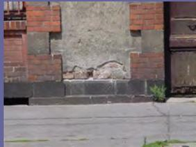
Desprendimiento de material por degradación progresiva de agentes erosivos y humedad capilar. Fachada principal.
