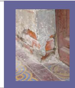
Capilaridad. Una de los cuatro tipos de humedades. Caracterizada por presentarse en el desplante de los muros por un fenómeno de gravedad. Al conservarse se empieza a debilitar el aplanado hasta desprenderse del muro.
