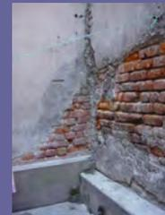
Presencia de fisuras con posibilidad a cambiar a grietas por organismos vegetales incrustados en muros
