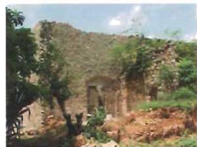
Muros restituidos y en ruina del presbiterio. Foto: A. Román
