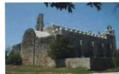
Vista NE de la capilla de indios original y nave de mampostería. Foto: A. Román
