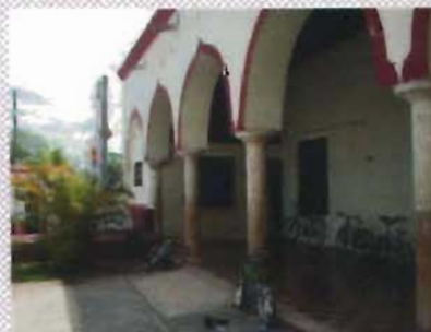
Corredor poniente de los anexos
