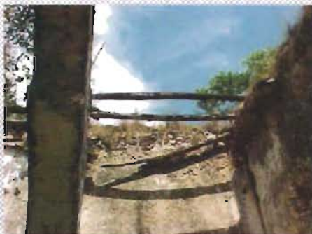
Vestigios de rollizos con canes en el anexo de la capilla de Tiholop, Yucatán
