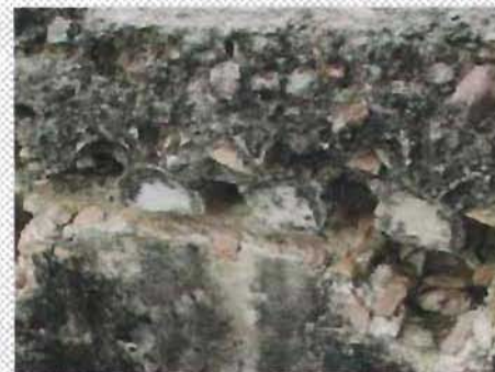
Detalle de mechinales. Se observa la conformación del as bovedillas con pequeñas piedras laja
