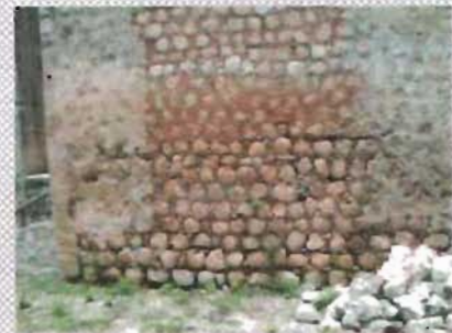
Detalle del aparejo del muro de mampostería nucleada
