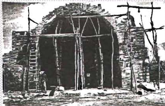
Cimbra utilizada a base de puntales en la reconstrucción de la bóveda de mampostería de la capilla de Dzibichaltún en 1962
