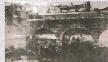
Vista norte de la arcada del Convento de San Francisco. Se observan los arcos de mampostería hechos con piedras tzales o laja. Foto: Archivo histórico Pedro Guerra en Alcalá: 1998: 67
