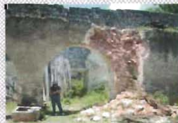
Detalle de arcada sur
