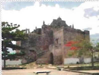
Vista SE de los anexos posteriores
