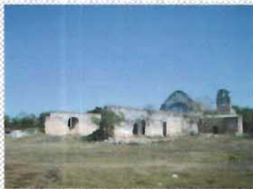
Vista SW de la capilla
