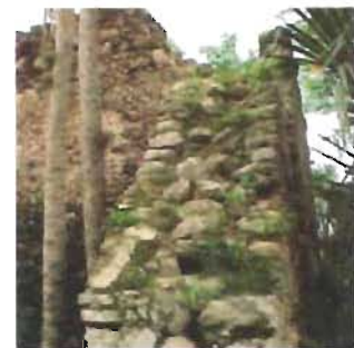
Detalle de muro de mampostería Foto: A. Román
