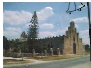
Vista NW de la nave de mampostería. Foto: A. Román
