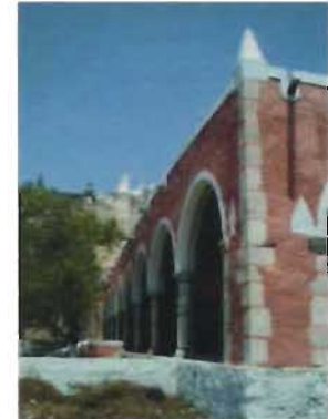
Crujía poniente de los anexos Foto: A. Román
