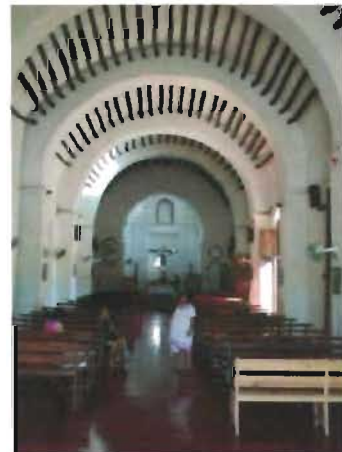
Bóveda de rollizos de arco rebajado en la capilla de San Juan Bautista, Abalá, Yucatán Foto: A. Román
