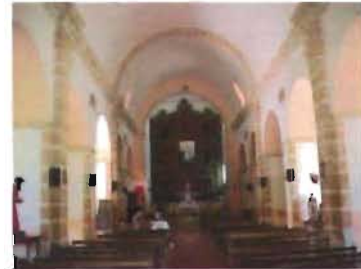
Contrafuertes formando capillas laterales en la iglesia de San Miguel Arcángel, Maxcanú, Yucatán Foto: A. Román
