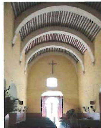
Vista de la nave hacia el acceso Foto: J. Novelo
