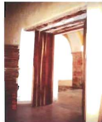
Dinteles de vigas en crujías del convento de la Asunción, Muna, Yucatán Foto: A. Román
