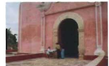
Jambas de cantería en portada principal de la capilla de San Juan Bautista, Xocchel, Yucatán. Foto: A. Román
