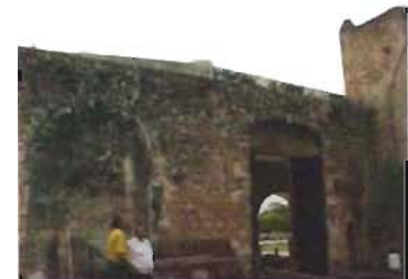
Muro de mampostería que soportaba a la ramada. Foto: S. Irigoyen
