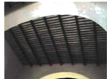
Techumbre de dos aguas en la nave de la capilla Foto: A. Román
