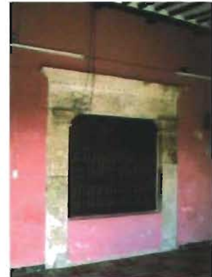
Dintel de piedra con labrado ornamentado en crujía de la capilla de San José, Espita, Yucatán Foto: A. Román
