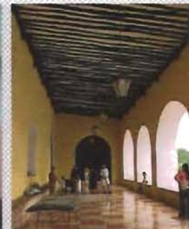
Vista NE de los portales
