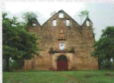
Fachada oeste de la capilla
