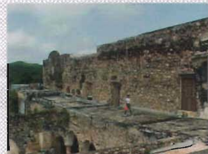
Fachada SO de la planta alta
