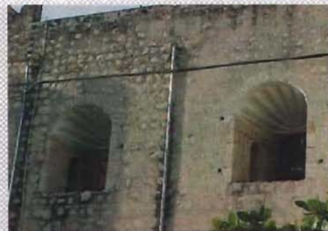
Detalle de muro y capialzados de mampostería
