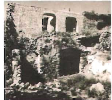
Crujía NE del convento en la década de los ochentas del S. XX Foto: México-SAHOP, 1982: 99
