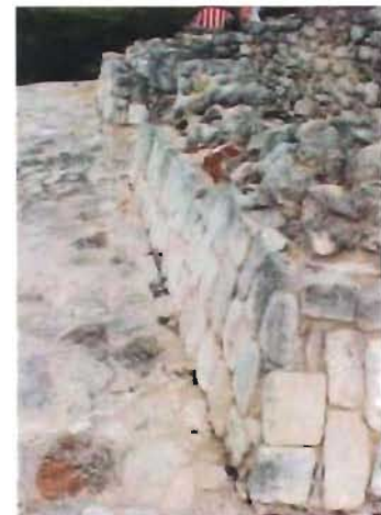
Arranque de muro de piedra chapa y núcleo de piedras y mortero en el Templo de Kukulcán, Mayapán, Yucatán. Foto: A. Román
