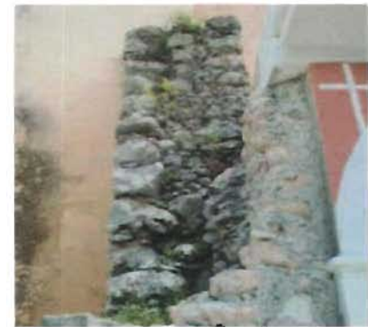
Detalle de muro de mampostería aparejada con dos paramentos de piedra careada y núcleo de piedras y mortero. Capilla de San Antonio de Padua, Chemax, Yucatán. Foto: A. Román
