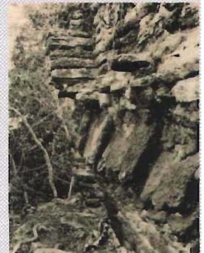
Arranque de bóveda de cañón en la pared norte del cuarto 2.
