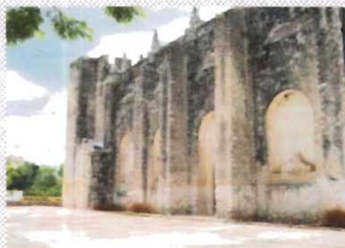
Contrafuertes y hornacinas exteriores en el paramento sur
