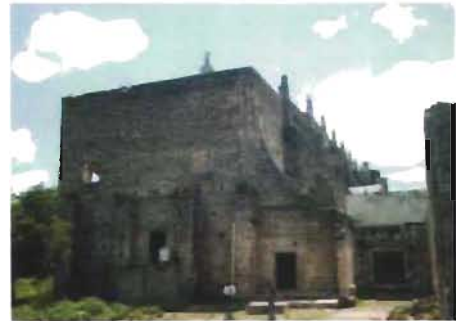
Paramento oriente de la sacristía y anexos. Foto: A. Román
