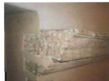
Detalle de cornisa perimetral Foto: A. Román
