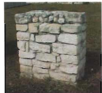
Pilar de sillarejos en el baño de vapor de Xcambó, Yucatán.
