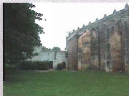
Vista NW de la nave y anexos
