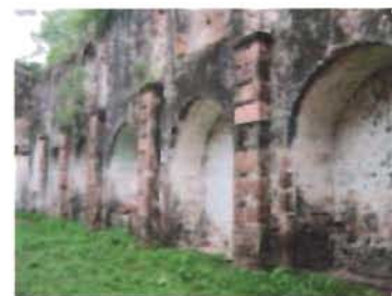
Contrafuertes y arcos formando capillas hornacinas Foto: E. Ácata
