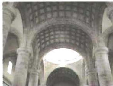
Bóveda baida con casetones de cantería en la catedral de San Ildefonso, Mérida, Yucatan Foto: A. Román
