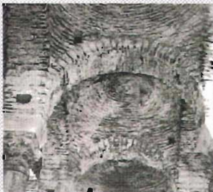
Aparejo circular en cúpula de mampostería de piedras laja
