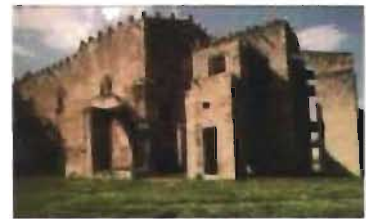
Arbotantes en ábside y camarín en el convento de San Antonio de Padua, Izamal, Yucatán Foto: México, SAHOP, 1982: 97
