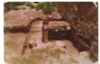
Cimiento de mampostería ordinaria junto a cimientos prehispánicos mayas. Foto: R. Burgos
