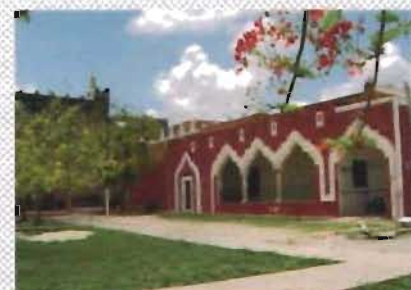
Arquería sur ampliación S. XVII Y XVIII
