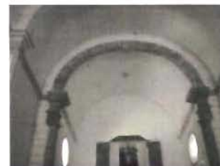
Bóveda de cañón del presbiterio. Arco triunfal de dovelas soportado por pilastras de cantería Foto: A. Román
