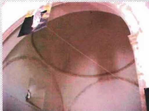
Cúpula de medio punto sobre pechinas en el presbiterio de la capilla de la Asunción, Kopomá, Yucatán
