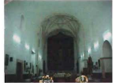
Interior de nave con bóveda de cañón y presbiterio con bóveda vaída. Foto: S. Irigoyen
