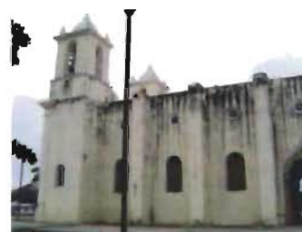
Torre del paramento sur de la nave Foto: W. Santos
