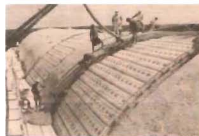
Detalle de la reconstrucción de la bóveda con elementos prefabricados de concreto Foto: Diario de Yucatán, sección local, p. 14, 23 de enero de 2000
