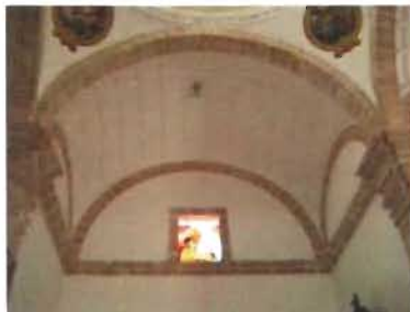
Bóveda baida con casetones de mezcla en la parroquia de Guadalupe, San Cristóbal, Mérida, Yucatan Foto: A. Cahrera
