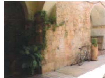
Piedras prehispánicas integradas en muro de mampostería Foto: A. Román
