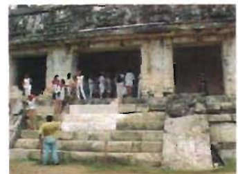
Pilares de mampostería con refuerzos de sillares en la Casa "C" del Palacio en Palenque, Chiapas.
