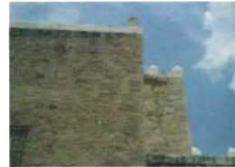
Cadena de refuerzo en una de las esquinas de la capilla de Santa Isabel, Ticuch, Yucatán Foto: G. Salazar
