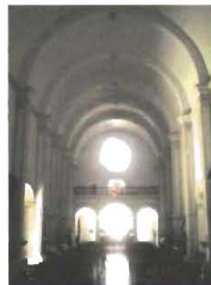
Interior de nave viendo hacia el acceso y coro. Foto: A. Román
