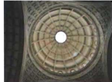
Cúpula de medio punto con linternilla y lunetos, con el intradós; intradós con casetones de cantería. Catedral de San Ildefonso, Mérida, Yucatán. Foto: A. Román
