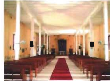
Interior de la nave con columnas, traveses y losa de concreto. Foto: A. Román
