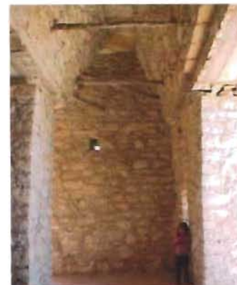
Muros de mampostería de sillarejos ordinaria y bóveda con lajas en el interior del Templo de las Siete Muñecas, Dzibilchaltún, Yucatán. Foto: A. Román
