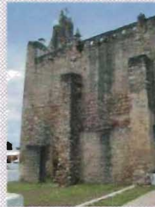
Contrafuertes empotrados en muro. Capilla de Santa Isabel, Ticuch, Yucatán
