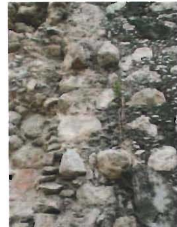
Detalle de traslapes en muros a cada tres o cuatro hiladas. Convento de la Mejorada, Mérida, Yucatán Foto: A. Román
