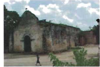
Vista SW de la capilla Foto: A. Román
