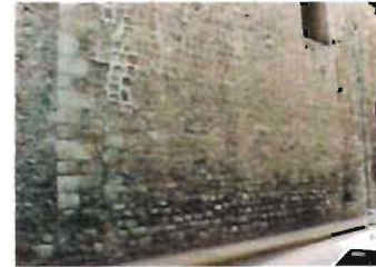
Se observa el paramento poniente el adosamiento entre el extremo sur del transepto y el baptisterio. Capilla de la Tercera Orden, Mérida, Yucatán Foto: A. Román
