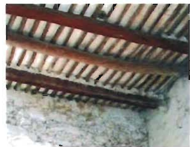
Techumbre de rollizos y rollicillos de madera en la crujía oriente de la planta alta del convento de San Juan Bautista, Tekax, Yucatán Foto: A. Román
