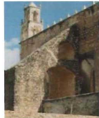
Arbotante en el paramento poniente de la iglesia conventual de San Juan Bautista, Motul, Yucatán Foto: F. Herrera
