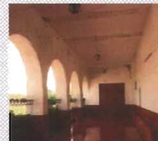
Corredor poniente acceso al convento
