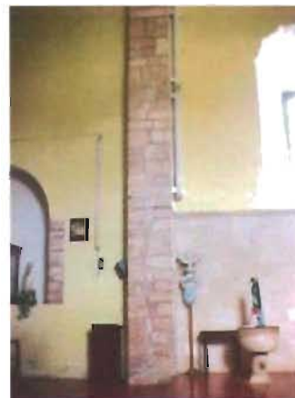
Pilastra de sillarejos en la capilla de la Asunción, Temozón, Yucatán. Foto: A. Román
