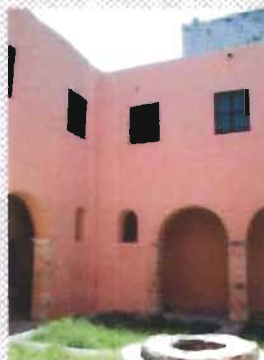
Vista SW del claustro y patio siglo XVI
