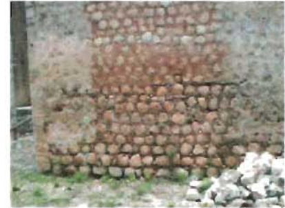
Muro de mampostería aparejada. Se observan las hiladas regulares con juntas anchas y cuatrapeo a cada dos hiladas. Capilla de Santa Isabel, Ticuch, Yucatán. Foto: A. Román
