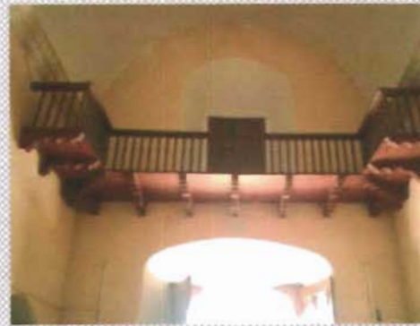
Coro de vigas en voladizo en la capilla de San Bernardino, Tetiz, Yucatán
