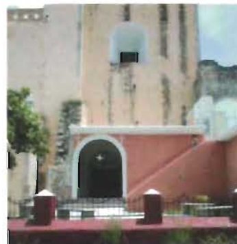
Vestigios del muro del primitivo baptisterio, en el paramento sur de la nave. Foto: A. Román
