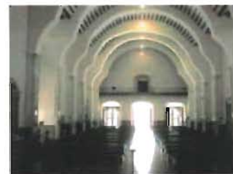
Bóveda de rollizos de arco escarzano con extremos rectos en la nave conventual de San Francisco, Hunucmá, Yucatán Foto: A. Román
