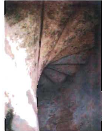
Lecho inferior escalonado alabeado de la escalera de cantería de la capilla de la Asunción, Kopomá, Yucatán Foto: A. Román
