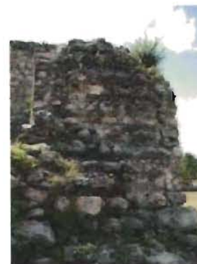
Detalle del muro de mampostería de la nave Foto: A. Román
