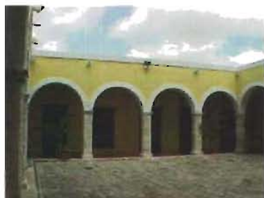
Arcos formeros de medio punto en el claustro del convento de Monjas, Mérida, Yucatán. Foto: A. Román
