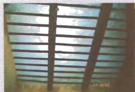
Techumbre en una de las crujiás del convento de la Asunción, Muna, Yucatán
