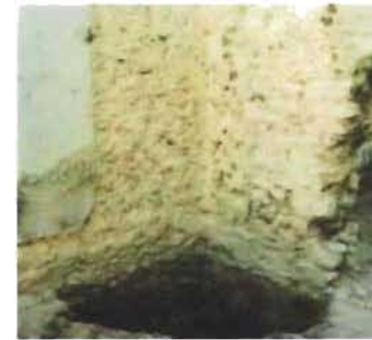
Cimiento en la hacienda de Xcanatún, municipio de Mérida, Yucatán.
