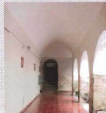
Corredor norte del claustro bajo
