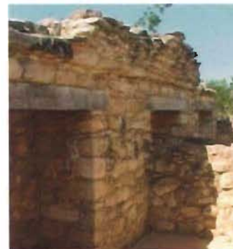
Arranque de bóvedas en crujía de la estructura 42, Dzibilchaltún, Yucatán. Foto: A. Román
