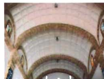
Detalle de arcos de dovelas desalineadas Foto: A. Román
