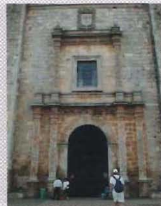
Muro de silleria en portada principal
