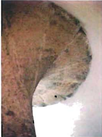
Lecho inferior alabeado continuo de la escalera de cantería de la capilla del Perpetuo Socorro, Mérida, Yucatán Foto: A. Román
