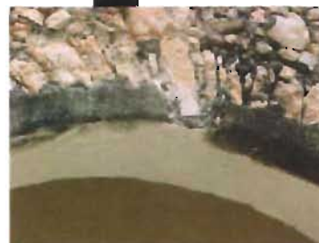
Detalle de clave y contraclave izquierda descentrados. Convento de San Juan Bautista, Tekax, Yucatán. Foto: A. Román
