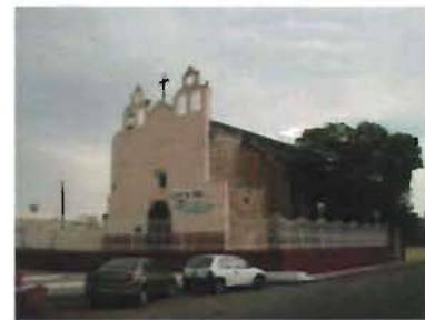
Vista SW de la capilla Foto: A. Román
