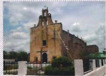
Vista SW de la capilla
