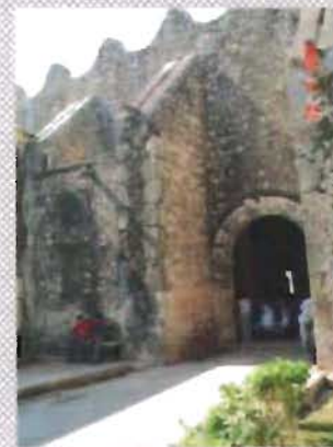
Contrafuerte adosado en muro. Capilla de Santiago, Halachó, Yucatán
