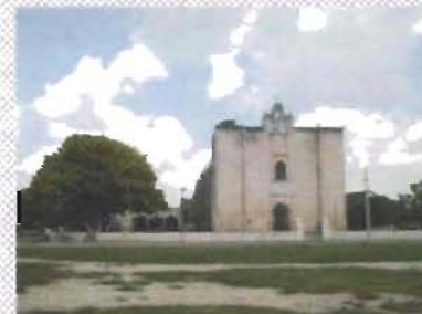
Vista poniente del conjunto doctrinal secularizado
