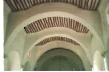
Bóveda de rollizos con forma de omega extendida en la capilla de San Lorenzo, Tahmek, Yucatán Foto: R. Canto
