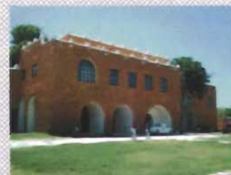
Ampliación crujía norte del convento
