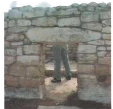
Dintel de piedra en el acceso de baño de vapor en Xcambó, Yucatán. Foto: A. Román
