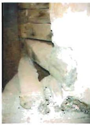
Escalera de caracol de madera con escalones independientes en la capilla de San Miguel Arcángel, Tixméhuac, Yucatán Foto: A. Román
