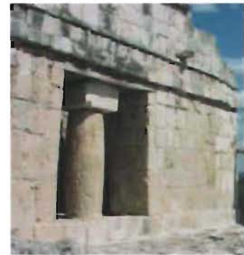
Columna monolítica con gálibo en el edificio de 5 plantas en Edzná, Campeche.
