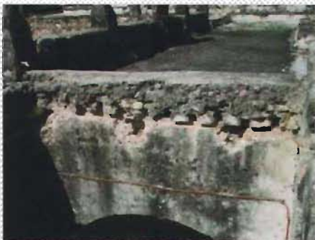
Mechinales de vigas, vigas de arrastre y canes en el rincón del claustro del convento de San Francisco, Oxkutzcab, Yucatán
