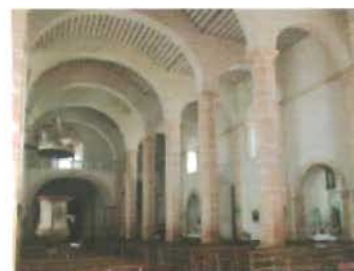
Pilares de sección ochavada en la iglesia conventual de San Francisco, Oxkutzcab, Yucatán Foto: A. Román
