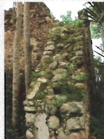
Muro con hiladas transversales en los anexos de la capilla de San Francisco, Popolá, Yucatán
