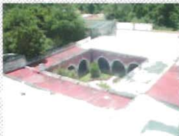
Vista área del conjunto de habitaciones y servicios
