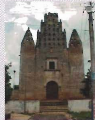
Vista de la fachada W
