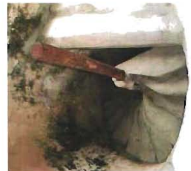
Escalera de madera con lecho inferior escalonado y escalones en ángulo en la capilla de San Juan Bautista, Xocchel, Yucatán
