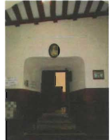
Jamba de mampostería en la capilla de San Bartolomé, Seyé, Yucatán Foto: A. Román
