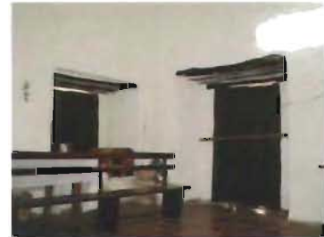
Dinteles de rollizos en anexos de la capilla de Santa Isabel, Ticuch, Yucatán Foto: A. Román
