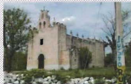
Vista SW de la capilla
