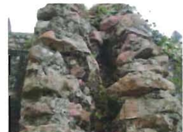
Detalle de las hiladas de piedras tzales en arco de mampostería. Convento de San Francisco, Oxkutzcab, Yucatán.
