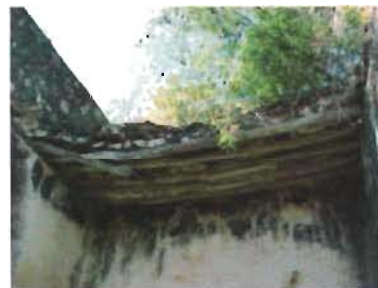
Detalle de techumbre de rollizos en anexo sur. Foto: A. Román
