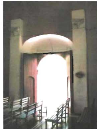
Vista interior del mismo capialzado San Antonio con vista interior en el acceso sur de la nave.
