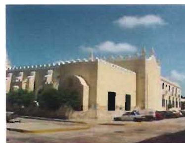
Vista de la fachada SE de la capilla lateral, presbiterio y anexos.
