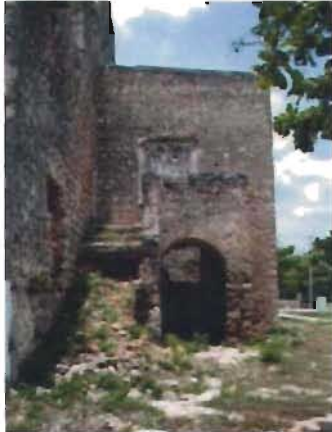
Escalera de rampa en ángulo. Se observa el relleno de la rampa y el muro de contención de mampostería. Anexo de la capilla de Santa Isabel, Ticuch, Yucatán Foto: A. Román
