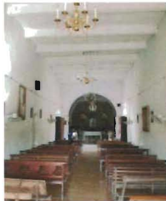
Interior de la nave con losa de concreto armado Foto: A. Román
