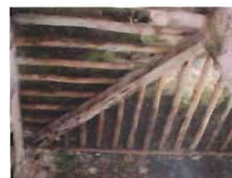
Detalle de techumbre de rollizos en esquina de los corredores del anexo. Foto: A. Román
