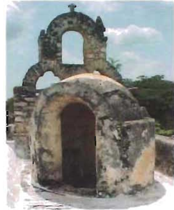
Caseta de la escalera con cúpula y capialzado de Marsella. Foto: A. Román
