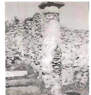
Columna aparejada con mampuestos Foto: A. Castro, 1999:35
