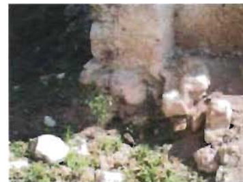
Cimiento en muro sur de la nave de la capilla de San Mateo, Kini, Yucatán Foto: A. Román
