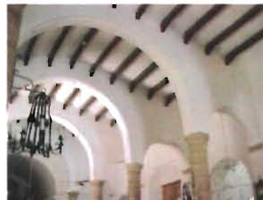
Techumbre de dos aguas de vigas y canes de madera.
