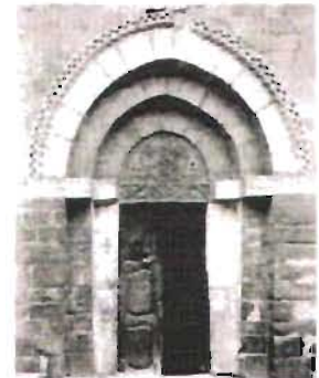
Arco dovelado con doble clave en la puerta de la iglesia de Bossost. Foto: A. Castro, 1999: 207
