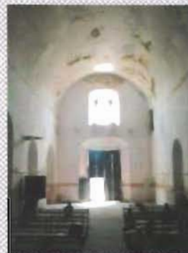
Interior de la nave hacia el acceso. Del coro solo quedan las vigas en voladizo
