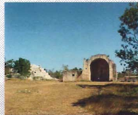
Vista poniente de la capilla.
