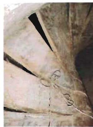
Escalera de caracol de madera con lecho inferior discontinuo y alabeado en la capilla de la Asunción, Tixcuytún, Yucatán Foto: A. Román
