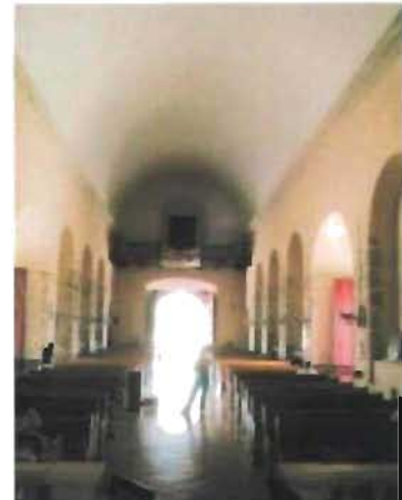
Vista de la nave hacia el acceso y coro Foto: A. Román
