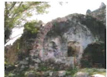
Arco en ruina en donde se observa la disposición radial de las piedras tzales con el salmen de mayores dimensiones. Convento de San Francisco, Oxkutzcab, Yucatán.
