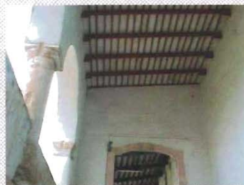
Techumbre en la crujía poniente de la planta alta del convento de San Juan Bautista, Tekax, Yucatán
