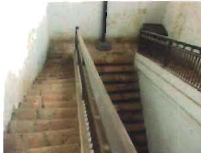
Escalera de tres tramos en el convento de San Juan Bautista, Tekax, Yucatán Foto: A. Román
