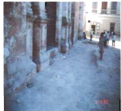
Arranque de la cimentación de sillares y sillarejos en la portada principal Foto: A. Román
