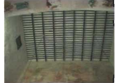
Techumbre de viguetas metálicas en la nave de la iglesia Foto: A. Román
