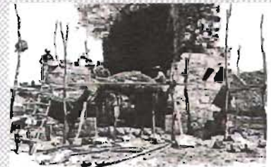
Cimbra de madera y piedra en la reconstrucción en 1962 del arco del muro sur de la capilla de Dzibilchaltún, Yucatán.
