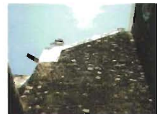
Detalle de contrafuerte en la iglesia de San Francisco, Hunucmá, Yucatán Foto: A. Román
