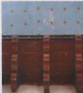
Detalle del coro con vigas en voladizo en la capilla de la Asunción, Tixcuytún, Yucatán
