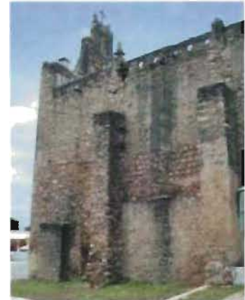
Evidencias de empotramiento en la parte superior del contrafuerte con el muro de la nave
