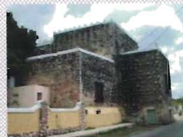
Vista SE de la antigua capilla de indios y camarín adosado
