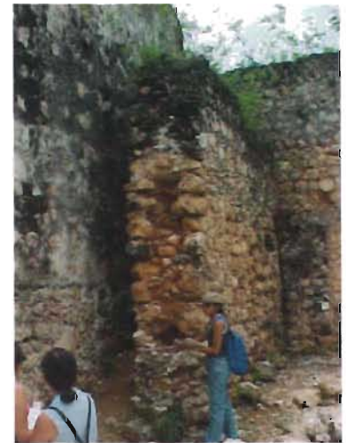
Detalle de muro de mampostería que indica el ancho que iba a tener la nave. Foto: A. Román
