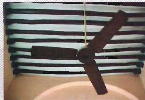
Techumbre de rollizos con canes en la crujía del convento de las Monjas Concepcionistas, Mérida, Yucatán
