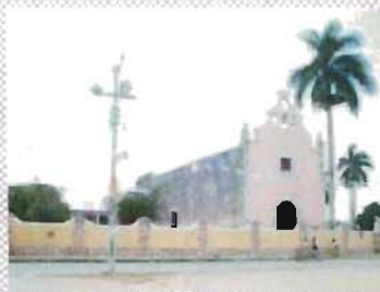
Vista SW de la nave de la capilla
