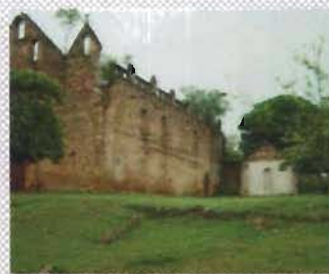
Paramento sur de la nave
