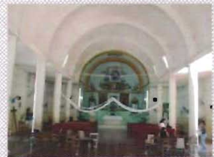
Interior de la nave con cubierta abovedada de concreto
