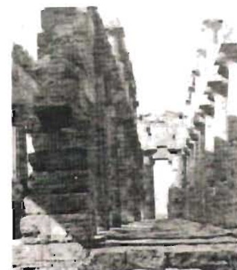
Sillares colocados a soga y tizón en muros de templos griegos.
