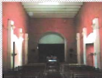
Vista de la nave hacia el presbiterio. Nave techada con trabes de concreto
