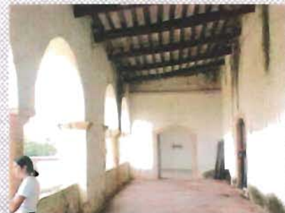
Corredor NW de la planta alta
