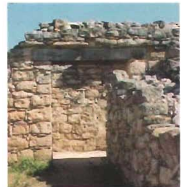
Dintel de madera en la estructura 42 en Dzibilchaltún, Yucatán. Foto: A. Román
