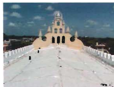
Azotea de la techumbre de dos aguas
