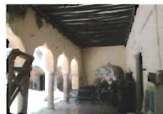
Columnas de tambor en corredor sur de la crujía posterior de la capilla de San José, Espita, Yucatán Foto: A. Román
