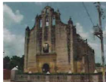
Vista SW de la capilla. Foto: A. Román
