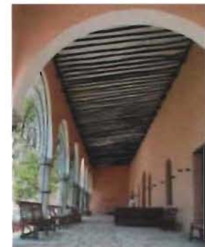
Corredor de la crujía poniente Foto: A. Román
