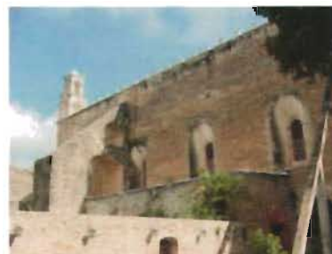
Paramento sur de la iglesia conventual Foto: F. Herrera
