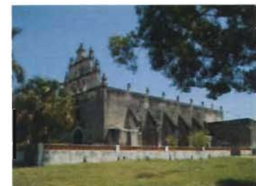
Vista SE de la nave de mampostería. Foto: A. Román
