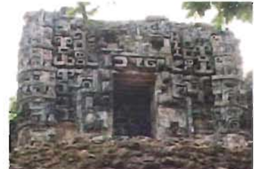
Dintel de madera en el acceso principal del edificio II en Hormiguero, Campeche. Foto: www.webcampeche.netfirms.com/campeche/hormiguero.htm
