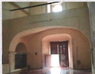
Bóveda vaída y arco de tres centros en el sotocoro
