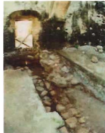
Cimiento prehispánico en crujía norte del convento S. XVI en Conkal, Yucatán. Foto: R. Burgos
