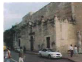
Capilla de Santa Ana adosada al paramento norte de la catedral Foto: A. Román
