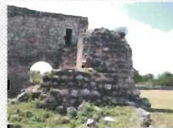
Detalle de las hiladas transversales en los muros de la capilla de San Mateo, Kini, Yucatán
