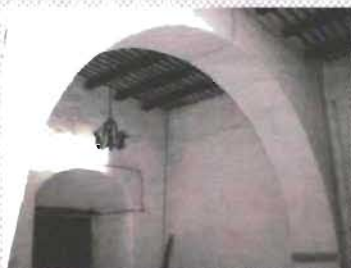
Techumbre de madera en el primitivo baptisterio
