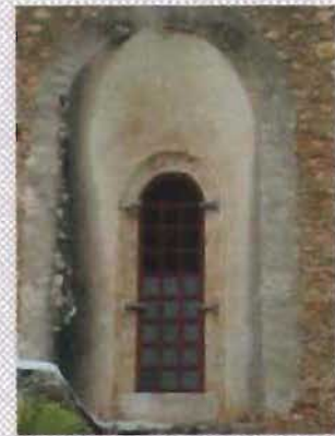
Capialzado compuesto tipo Marsella en la iglesia conventual de San Juan Bautista, Motul, Yucatán
