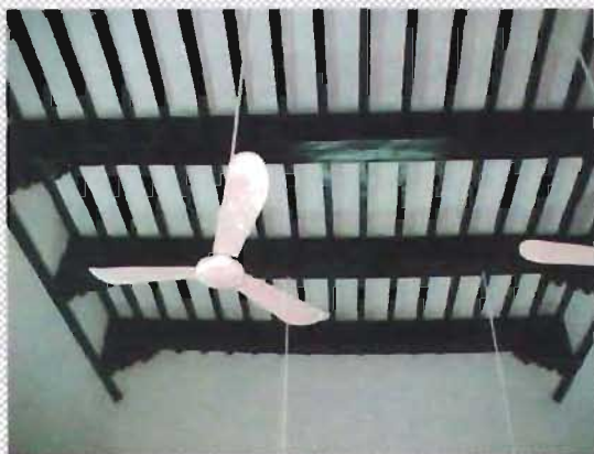
Techumbre de vigas y viguetillas con vigas de arrastre y canes en el anexo de la parroquia de Nuestra Señora de Guadalupe, San Cristóbal, Mérida, Yucatán
