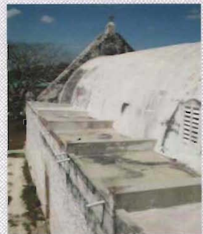
Azotea de la cubierta abovedada de concreto
