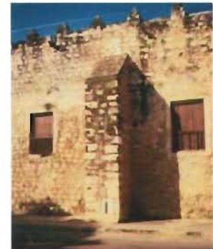
Contrafuerte en la crujía sur del convento de La Asunción, Muna, Yucatán. Foto: A. Román
