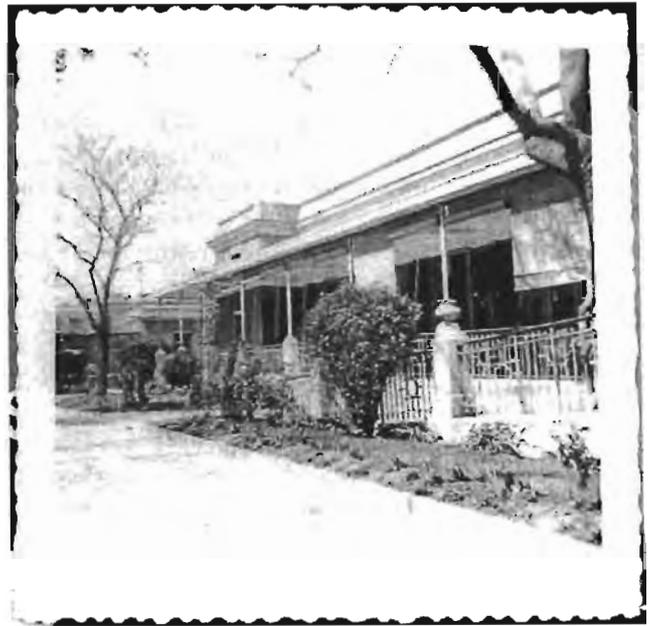
*Siguiendo los lineamientos del Código Sanitario, la construcción se desplantó arriba del nivel de piso para ventilar de manera cruzada.*
