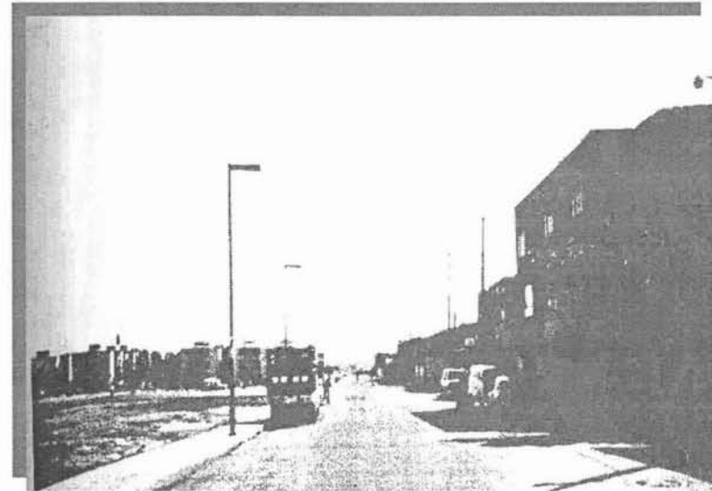
VISTA LAT. IZQUIERDA DE AV. IZTACIHUATL HACIA EL TERRENO
