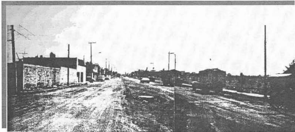
IMAGEN DE LA VISTA LAT. DERECHA DE AV. IZTACIHUATL AL TERRENO.
