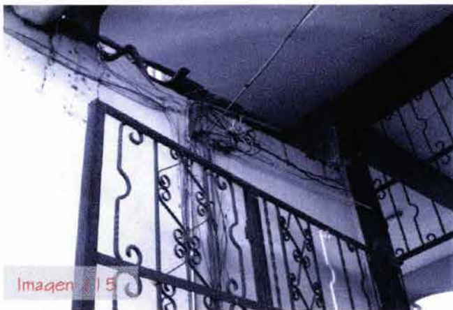
Instalación eléctrica en pórtico.
