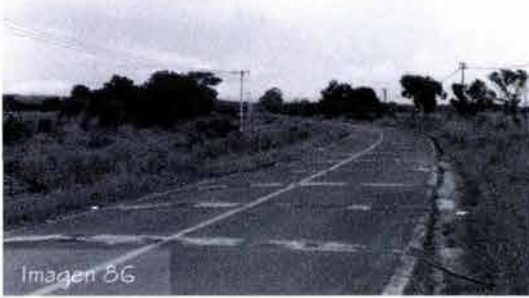
Carretera de entrada a Hueyapan.
