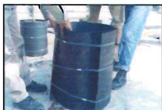
Foto 15. Colocación de flejes
