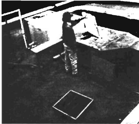
Figura No. 5.135. Cambio de filtros tipo bolsa para equipos de tipo dividido.
