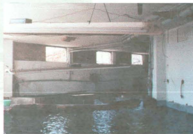
Vista interior de área de servicio
