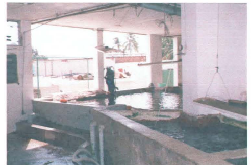
Vista interior de área de servicio
