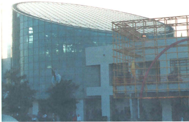
Vista exterior del invernadero
