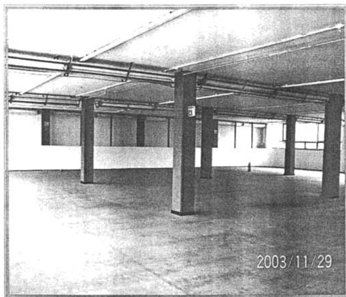
Figura 4.8.a. Vista general del sistema de piso
