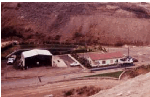
Figura 4.2 Vista general de las oficinas administrativas y cobertizo
