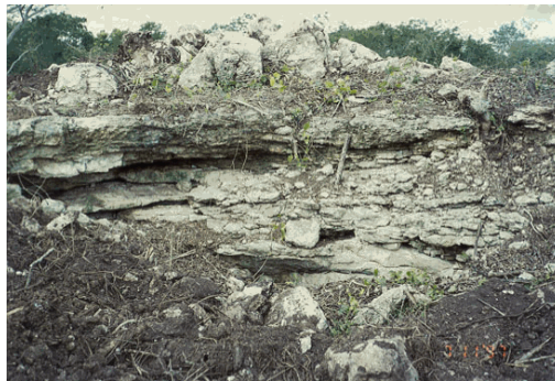
Figura 6.1 Cavidades y conductos de disolución generados por la acción cársica de la roca caliza
