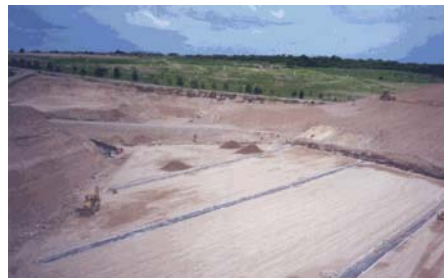
Fig. 5.1 Drenaje de lixiviados
