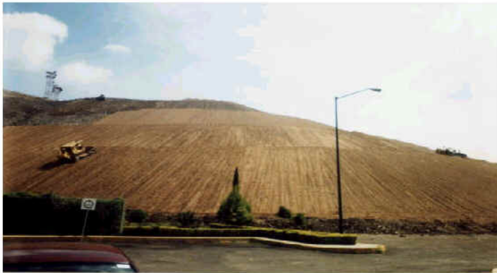
Figura 4.11 Estado final del tiradero saneado y rehabilitado
