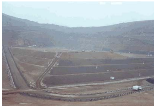
Figura 4.10 Vista de la construcción de acuerdo a proyecto.
