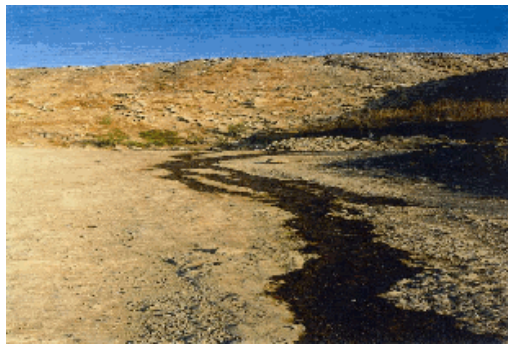
Figura 5.2 Afloramiento de lixiviados en el relleno sanitario
