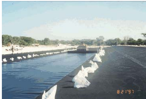
Figura 6.4 Instalación de geomembrana de polietileno de alta densidad
