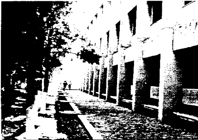
Figura II.9 Vista Posterior del Edificio A2 (Parte Trasera)
