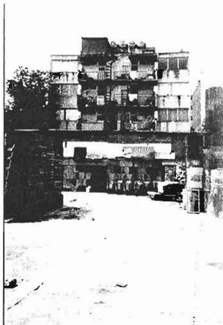
COLINDANCIA SUR, EDIFICIO DE CUATRO NIVELES
