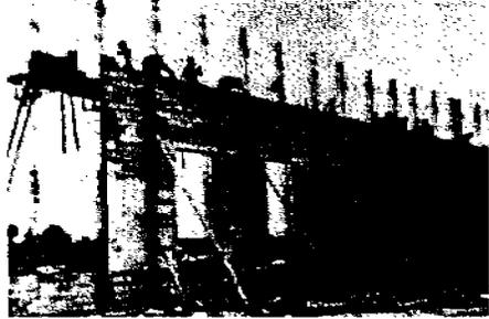
Figura 4.6. PROTECCIÓN DE UN MURO MEDIANTE ARRIOSTRAMIENTO PROVISIONAL.
