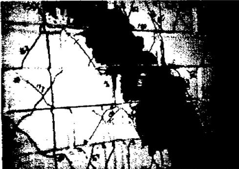
Figura 5.16. PREPARACIÓN DE LA SUPERFICIE DE UN MURO DE MAMPOSTERÍA CON RESINA EPÓXICA.
