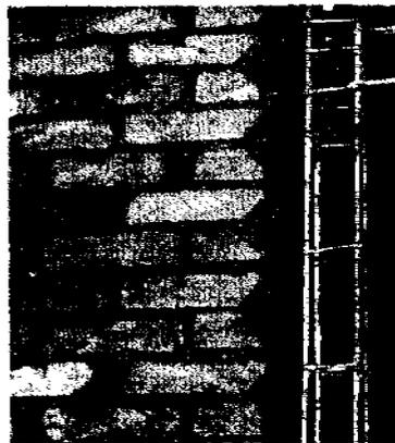
Figura 4.4. DENTADO DE UN MURO DE TABIQUE RECOCIDO PARA GARANTIZAR EL "AMARRE" CON LOS CASTILLOS DE CONFINAMIENTO.
