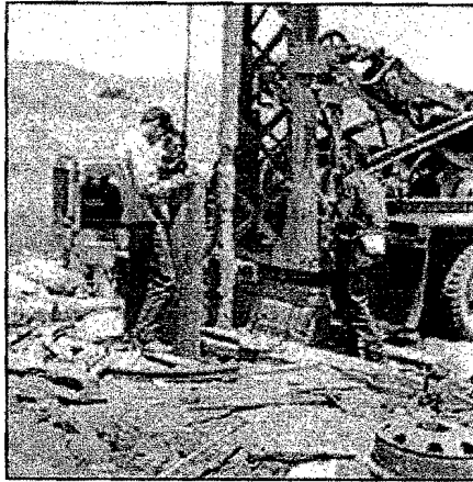
Figura 1.3. Perforación de pozos.
