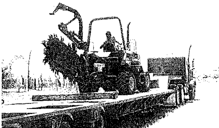
Figura 15. Zanjadora para tramos urbanos especiales.
