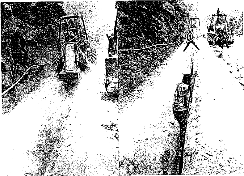
Figura 38. Instalación de flexoducto en cuneta con maquinaria mayor.
