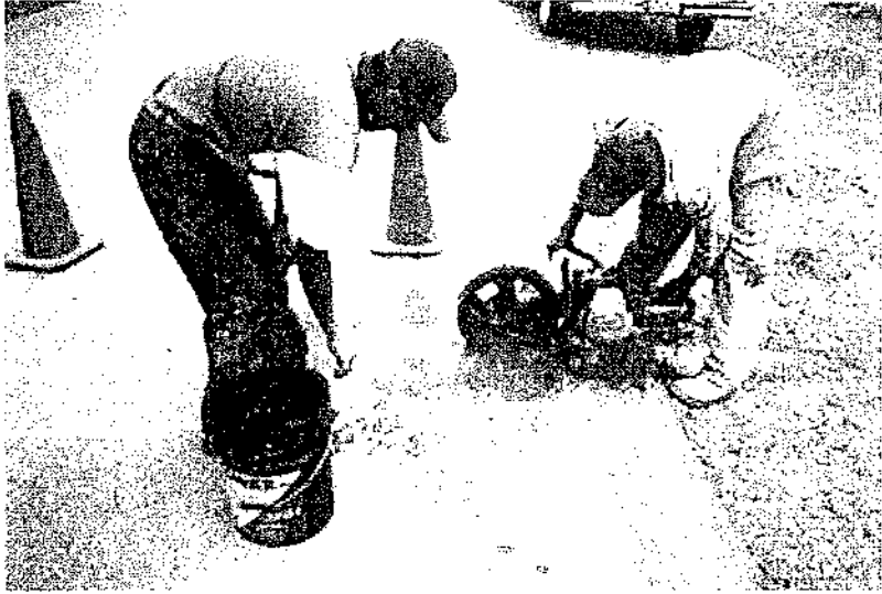
Figura 61. Corte del revestimiento con maquina cortadora de disco.
