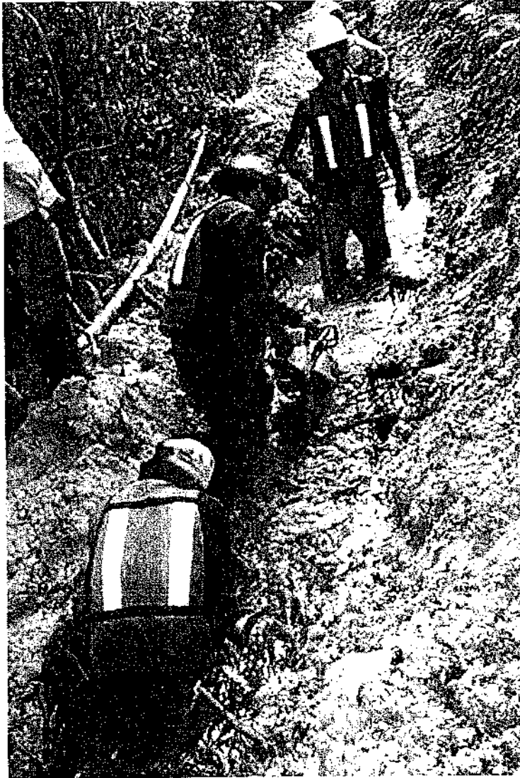
Figura 45. Trabajadores en zona de mangle cortando raíces con motosierra, con el flexoducto a un lado preparado para su colocación.
