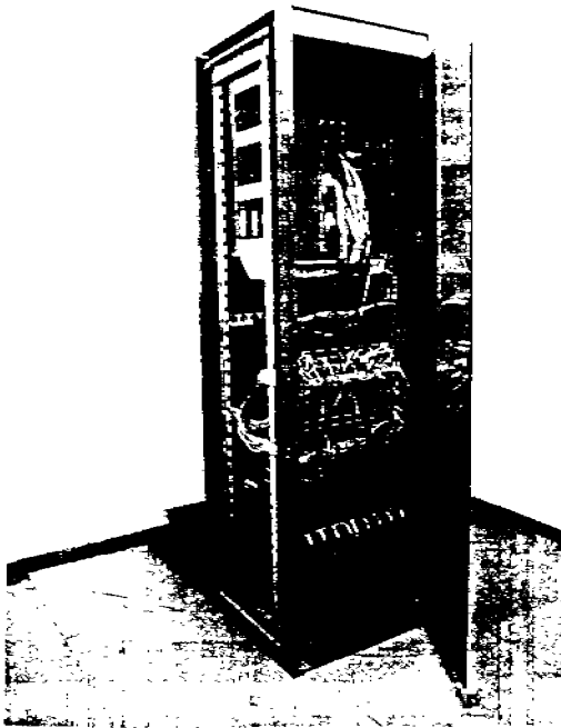
Figura II.14.- Vista General del repartidor de Planta (electrónica de red).
