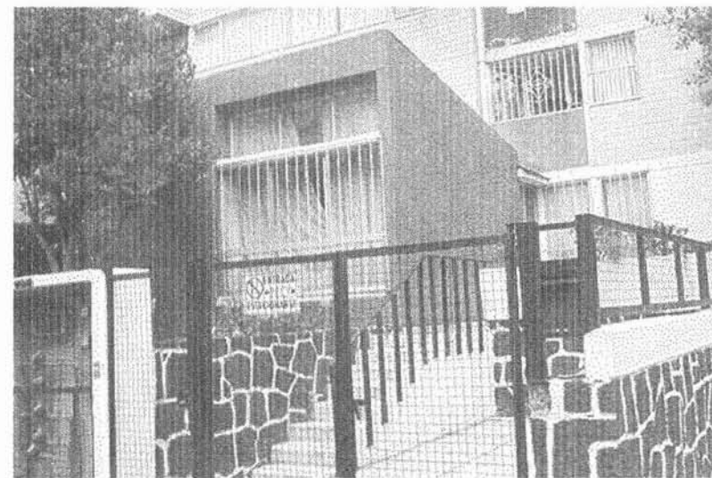
ACCESO INDEPENDIENTE ( VISTA DE SALA-COMEDOR )
